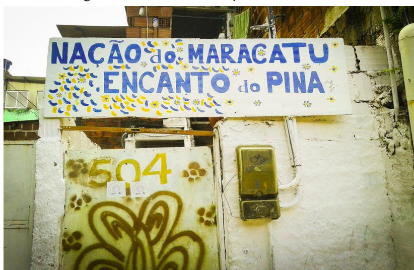
Figura 5 — Fachada da Nação antes da reforma
