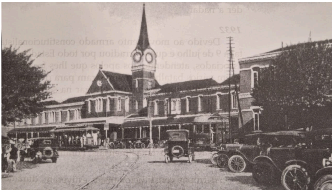
Figura 7 – Chegada do Bonde de Sousas, 1936
