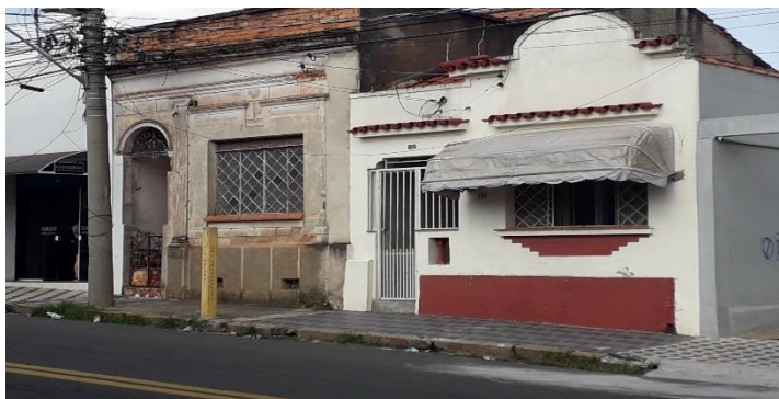
Imagem 3: Ruína de casa à rua Santa Maria com arcos (lembrando a cultura de origem árabe como os palácios árabes), fachadas estreitas, casas simples e conjugadas. (Foto do autor)
