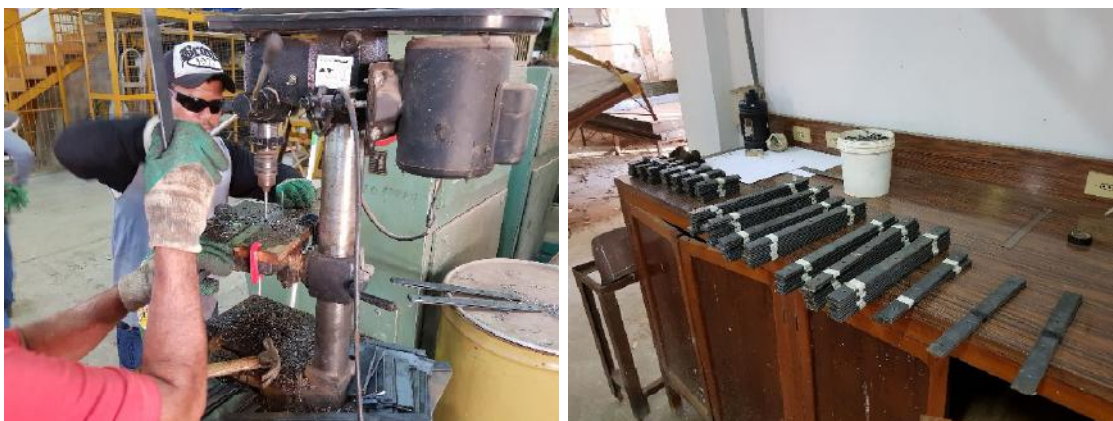
Figura 3.10: Confeção dos “studs”.
