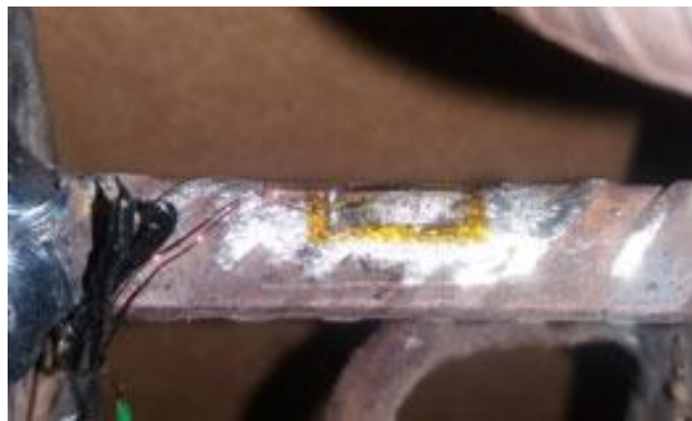
b) Fixação de extensômetro em armadura de flexão
