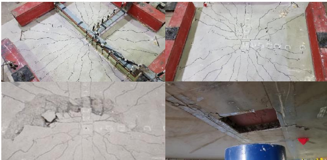
Figura 4.12: Fissuração e aspectos gerais após ruptura da laje LRC
