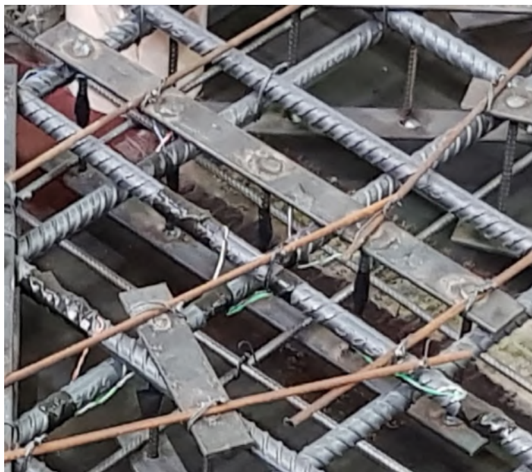
d) Visão geral dos extensômetros nas armaduras com fita isolante
