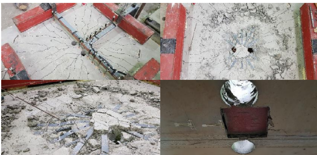
Figura 4.14: Fissuração e aspectos gerais após ruptura da laje L50F
