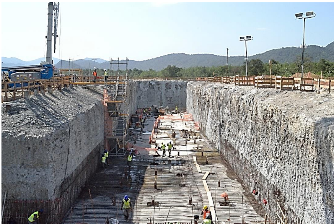
Figura 56 - Vista geral do Setor C (Fonte própria).
