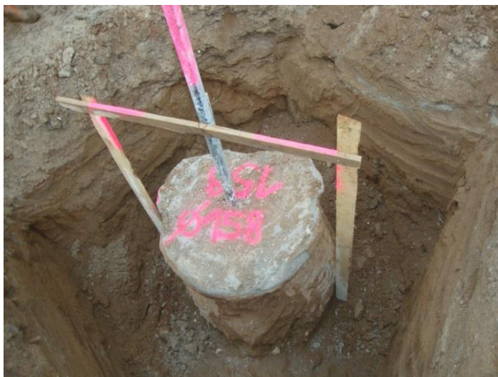
Figura 21 – Coluna experimental com jet grouting, escavada (Obra no metrô Thessaloniki, dezembro 2013)
