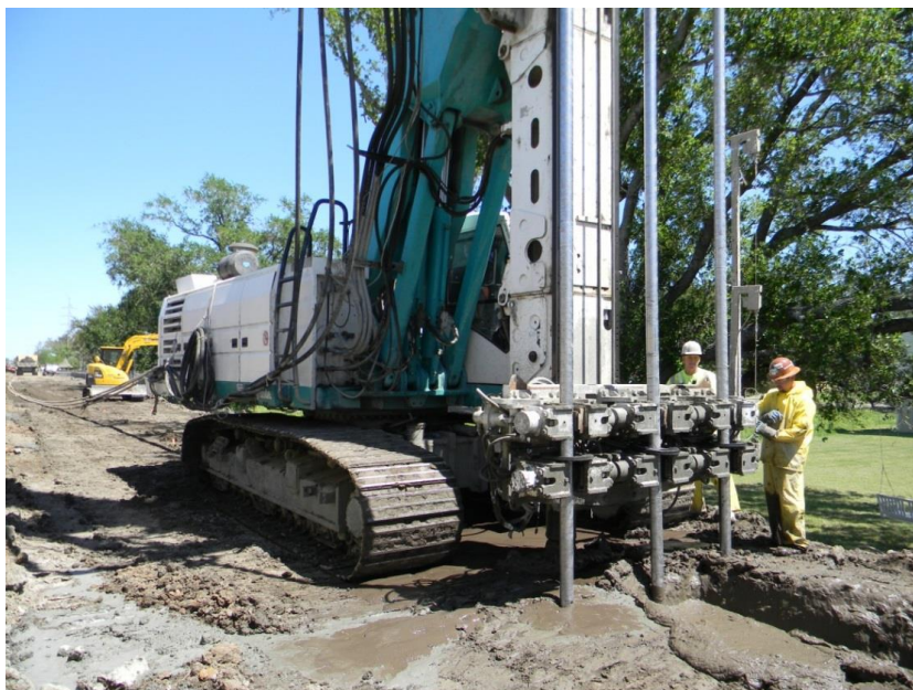
Figura 9 - Equipamento de haste tripla de injeção, “triple head” (Costa Fortuna, 2015).
