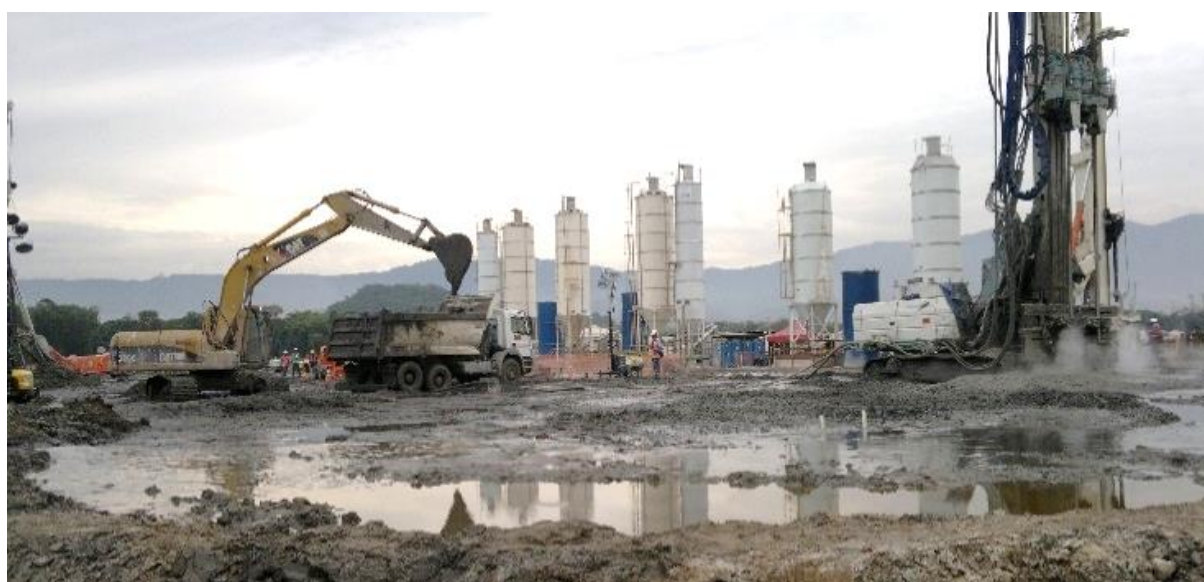
Figura 92 – Layout disposto em obra com os silos de cimento para posterior mistura, bombeamento e execução das colunas JG. Foto da obra (Fonte própria)
