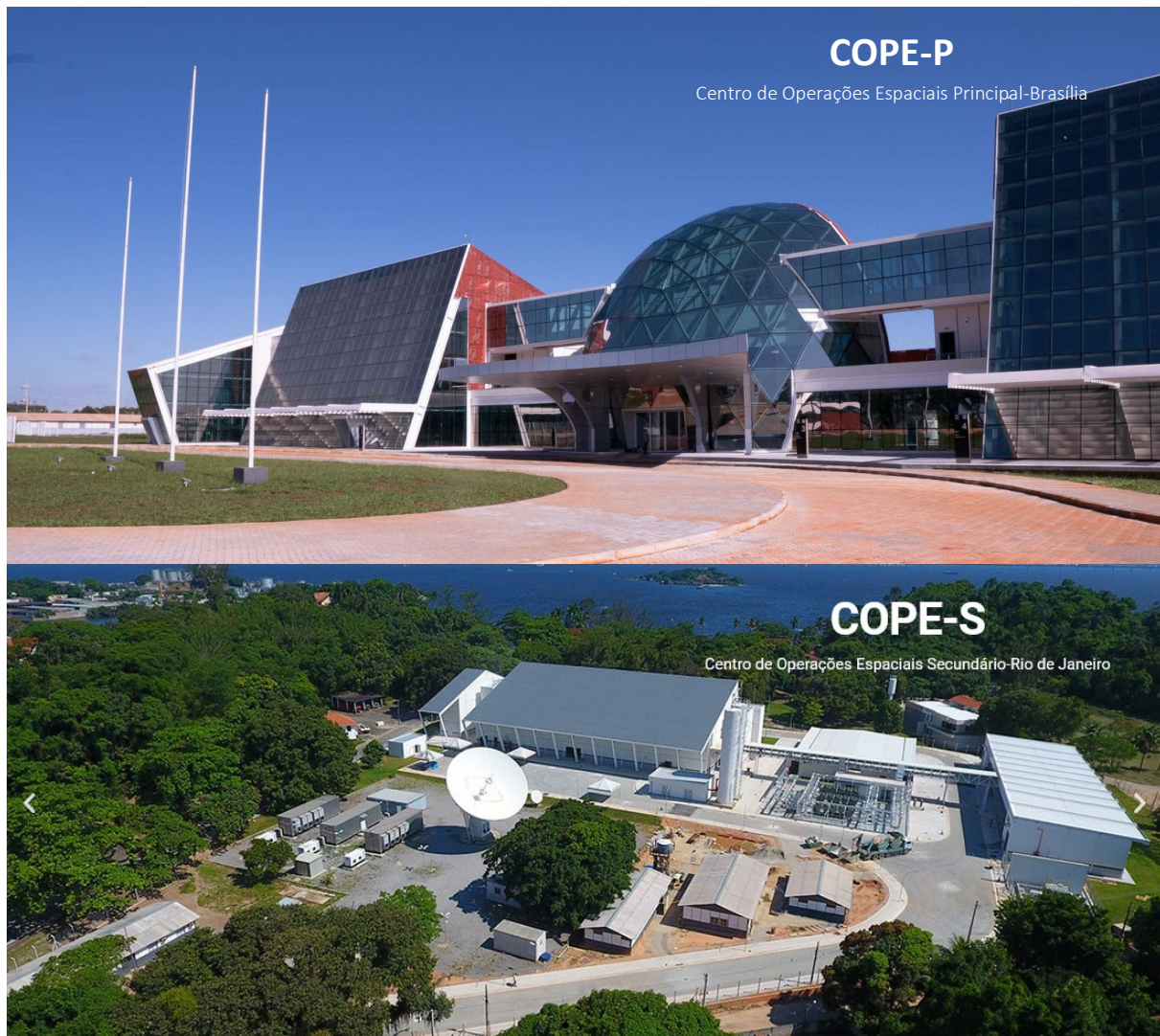
Figura 7: Instalações físicas dos gateways COPE-P e COPE-S.
