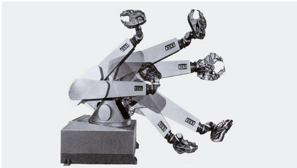
**Figura 14 – Primeiro robô industrial com seis eixos**
