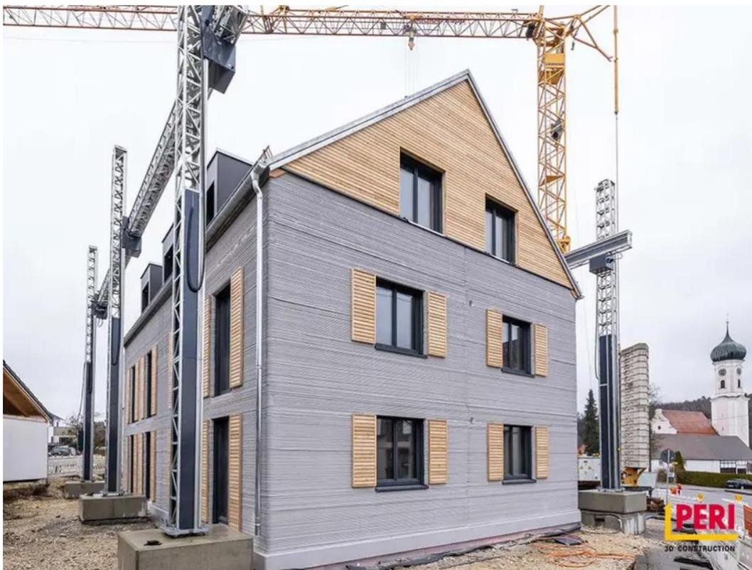
Figura 46 – Casa de três pavimentos impressa em 3D
