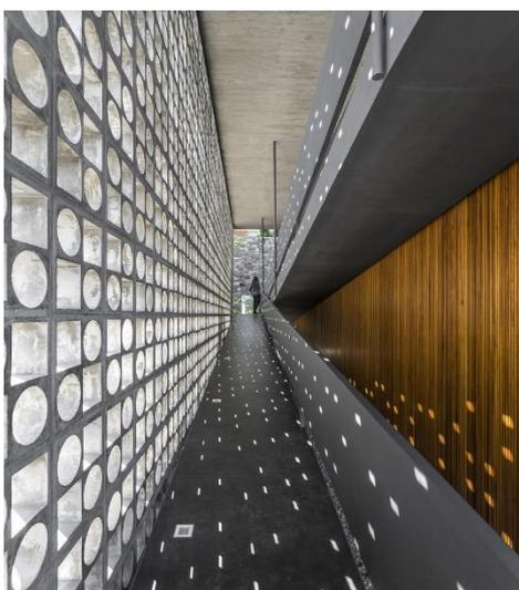
Figura 154 – Iluminação gerada por cobogó
