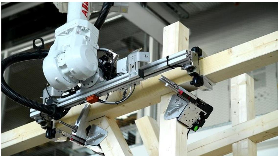
**Figura 94 – Detalhe de estrutura sendo montada com encaixes em madeira**
