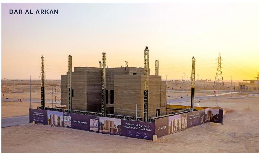
Figura 47 – Vila sendo impressa em 3D com uso de robô porticado
