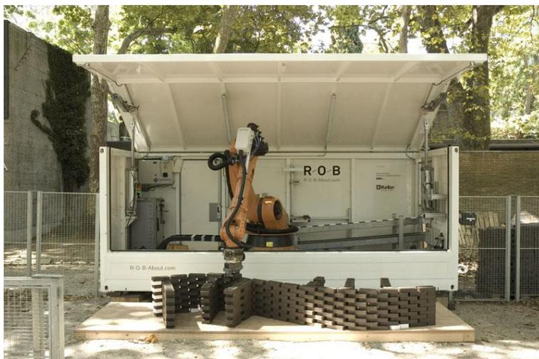
**Figura 28 – Montagem de parede utilizando braço robótico ROB**
