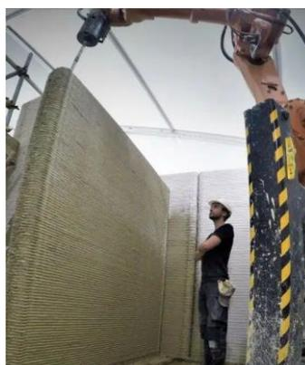
**Figura 42 – Braços robóticos realizando impressão 3D segmentada**
