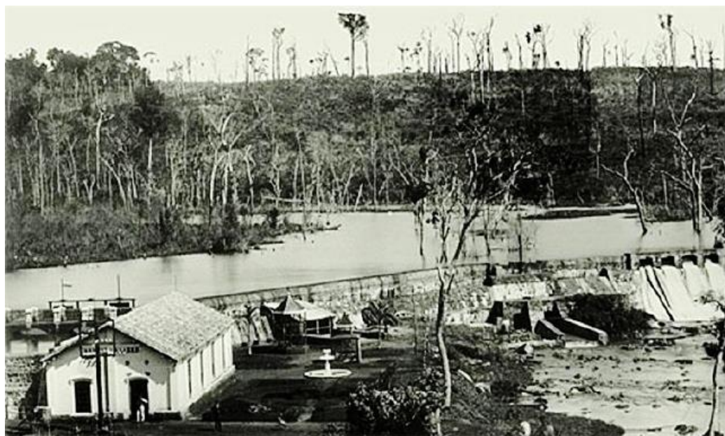
Figura 22. Antiga Usina de São Manuel, [19--]
