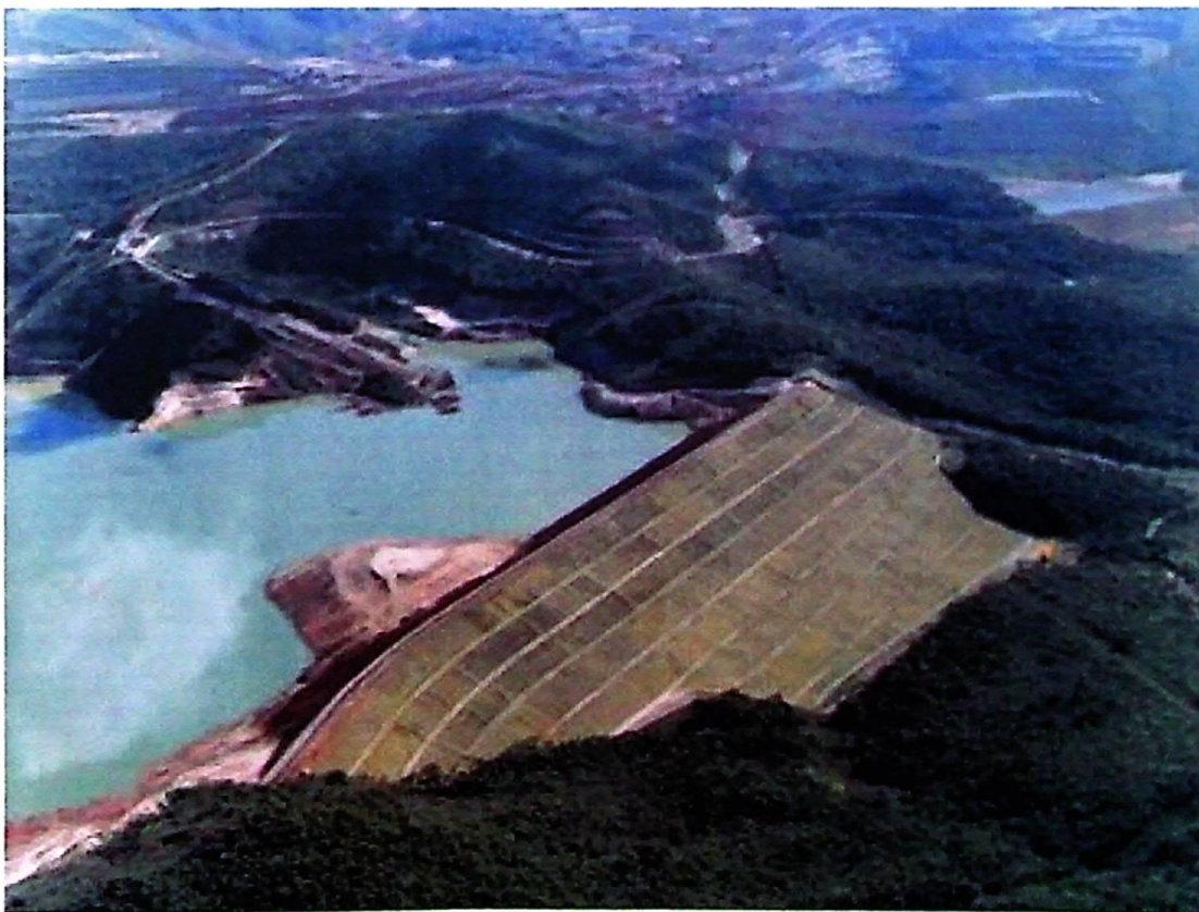
Figura 3: Barragem de rejeito Brucutu do Sul, Minas Gerais (Fonte: www.fidens.com.br )
