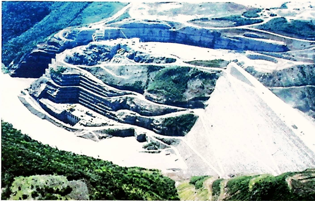
Figura 5: Barragem de enrocamento com núcleo argiloso, UHE Corumbá, Rio Corumbá, Goiás (Fonte: www.adrenaline.com.br )
