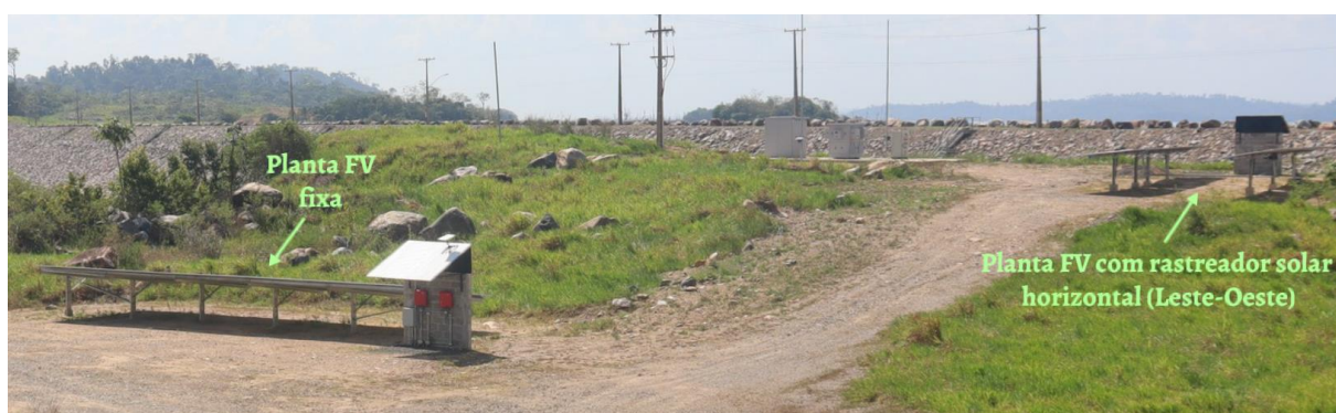
Figura 1.2: Plantas fotovoltaicas instaladas no solo na UHE Pimental
