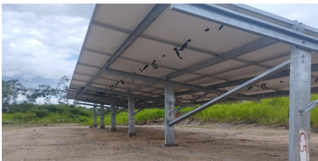
Figura 5.12: Registro da estrutura de suporte instalada sob terraplanagem realizada
