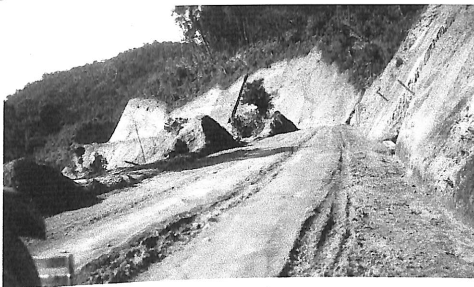
Figura 1 – Trecho da Serra já pronto para passagem de automóveis
