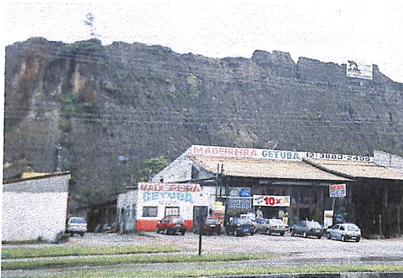
Figura 18 - Construção próxima a blocos de rochas
