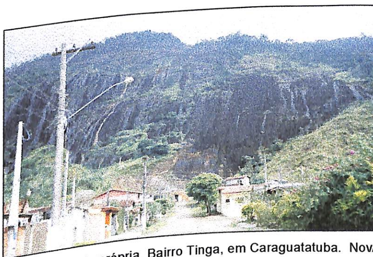
Figura 10 – Rochas expostas e samambaias, evidências de uma área onde já ocorreram escorregamentos
