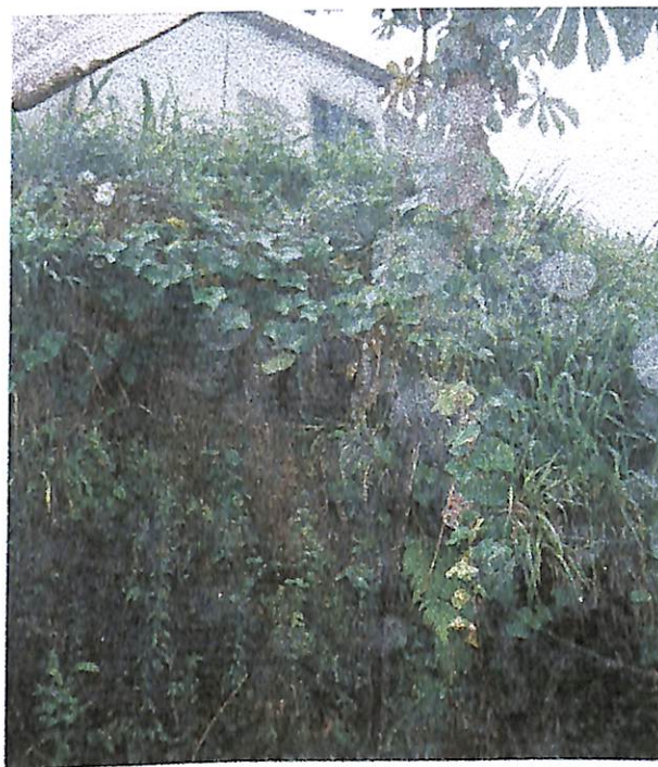
Figura 13 – Talude – corte vertical da encosta
