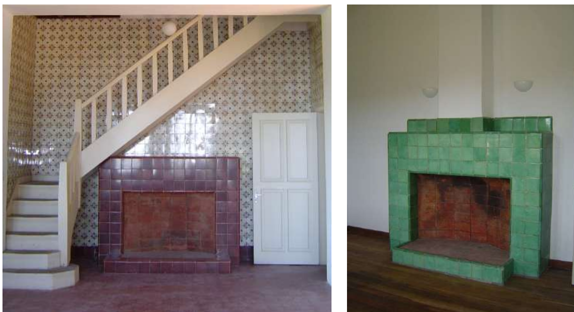
Figura 173: Vista da parede revestida por azulejos tipo padrão com a lareira, no centro, revestida por azulejos e cantoneiras monocromáticos. Vista da segunda lareira revestida por azulejos do Pouso Paranapiacaba. Acervo pessoal da autora. Foto de Mariana Ginese. Data: 06/07/2006.
