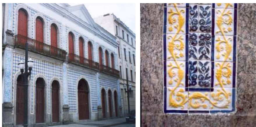
Figura 54: Fachada revestida com azulejos relevados - Edifício “Frontaria Azulejada”, Santos, SP. Acervo pessoal da autora. Data: 11/07/2004
