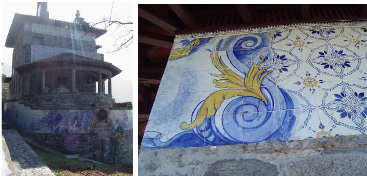
Figura 143: Fotografia da fachada curva do Rancho da Maioridade na qual podemos observar a aplicação de azulejos próximo ao telhado, nas paredes da varanda superior e inferior. Figura 144: Detalhe do arremate lateral com a representação de folhagens, guirlandas e volutas nas laterais do pano de azulejo de repetição posicionado nas paredes próximo ao telhado. Acervo pessoal da autora. Fotos de Mariane Ginese. 06/07/2006.
