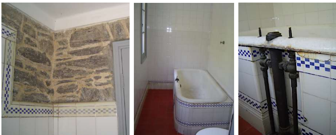
Figura 159, Figura 160 e Figura 161: F Fotografias dos banheiros do Rancho da Maioridade com detalhes do acesso da tubulação de água para o abastecimento da banheira e dos acabamentos das quinas com as cantoneiras cerâmicas, os rodapés e os frisos decorados. Acervo pessoal da autora. Foto de Mariana Ginese. Data: 06/07/2006.
