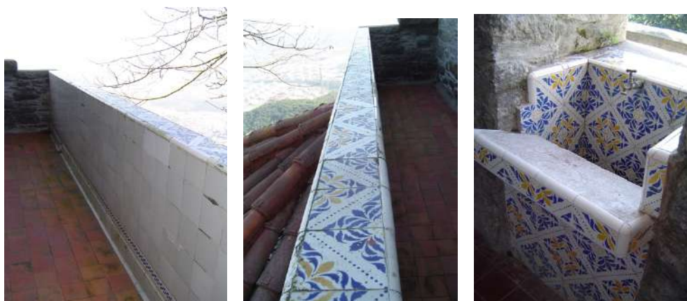
Figura 146: Fotografia do Guarda-corpo revestido por azulejos, rodapés e cantoneiras da varanda voltada para a fachada principal curva do Rancho da Maioridade. Imagem: Detalhe do muro da varanda onde se pode observar a aplicação das cantoneiras e dos azulejos de repetição. Imagem: imagem do tanque revestido por azulejos e cantoneiras cerâmicas brancas localizado no pavimento inferior do rancho da maioridade. Acervo pessoal da autora. Fotos de Mariana Ginese. Data: 06/07/2006.
