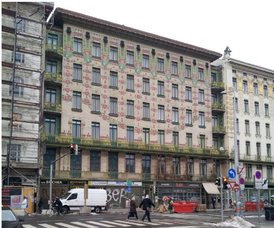
Figura 35: Fachada da Majolikahaus (Linke Wienziele 40, Viena, Áustria) – edifício projetado por Otto Wagner em 1898. Azulejaria pintada por Alois Ludwig. Acervo pessoal da autora. Data: 11/02/2015.
