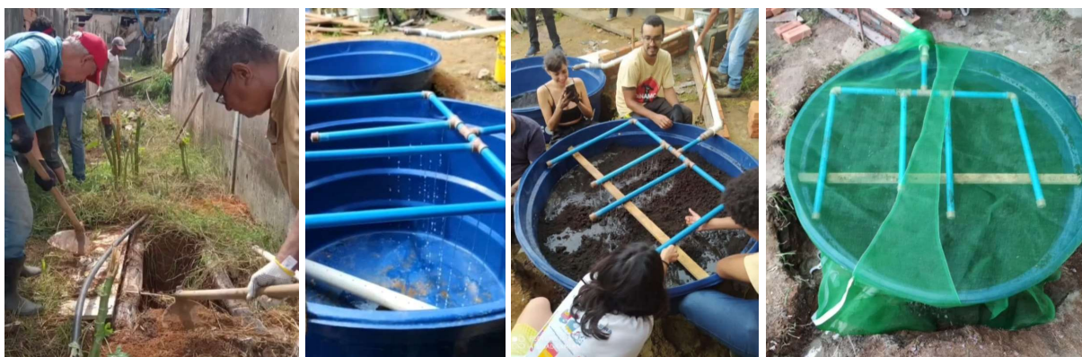
Figura 53 - Mutirões para construção de um sistema de tratamento de esgoto da cozinha comunitária do Acampamento Marielle Vive organizado pelo Coletivo Dínamo
