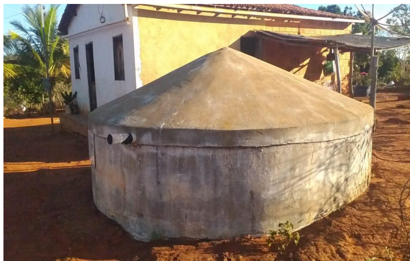
Figura 16: Cisterna normalmente presente na comunidade Barreiro
