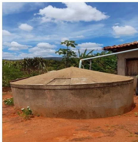
Figura 5: Cisterna para captação de água da chuva.
