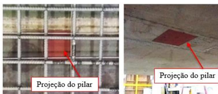
**Figura 3. 28 Marcação da projeção do pilar.**
