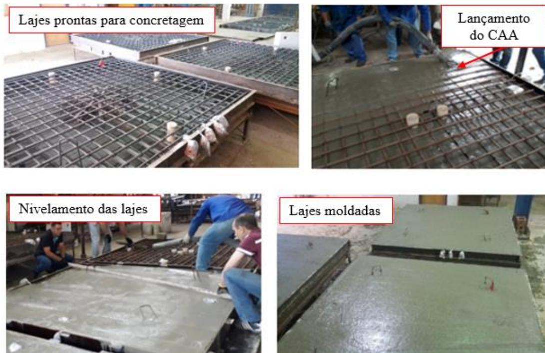
**Figura 3. 30:** Execução da concretagem.
