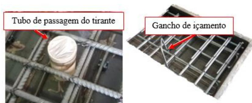
**Figura 3.21** Detalhe do posicionamento do tubo para os tirantes e ganchos.
