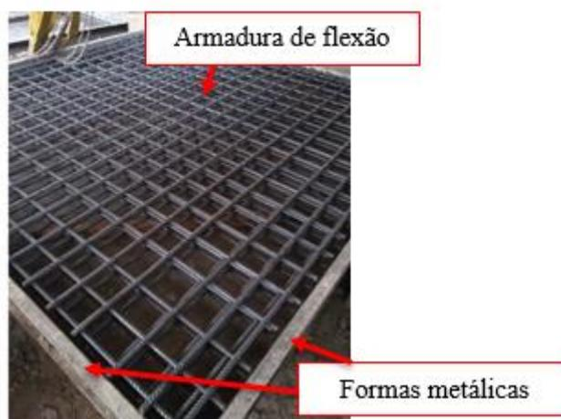
**Figura 3.20** Armaduras de flexão tracionada das lajes .
