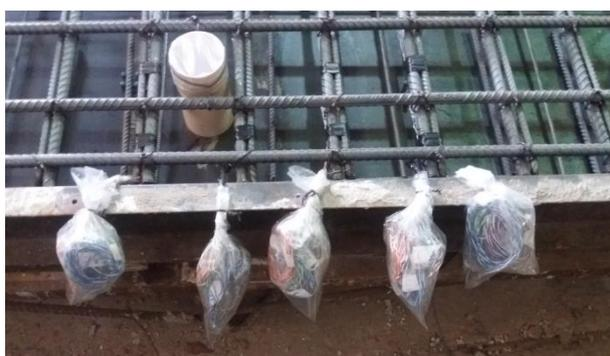
Proteção dos fios dos extensômetros.
