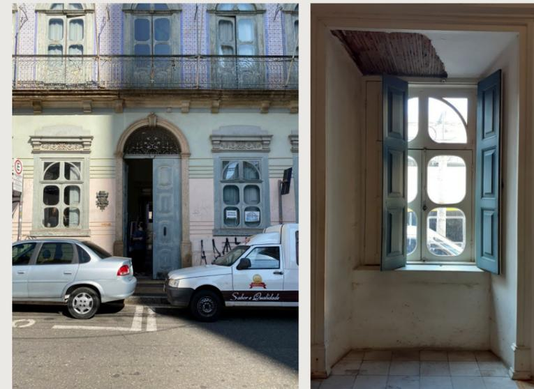
Fig. 58 e 59 - Palácio dos azulejos. Fachada (esquerda); Janela (direita). Notar que ambos encontram-se desgastados pelo tempo, com presença de rachaduras, danificações e pintura descascando. Foto da Autora. Data: Maio de 2022.
