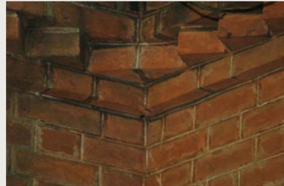
Fig. 67 - Exemplo de cimalka com friso de tijolos. Fonte: BERTUCCELLI ET AL., 2008.
