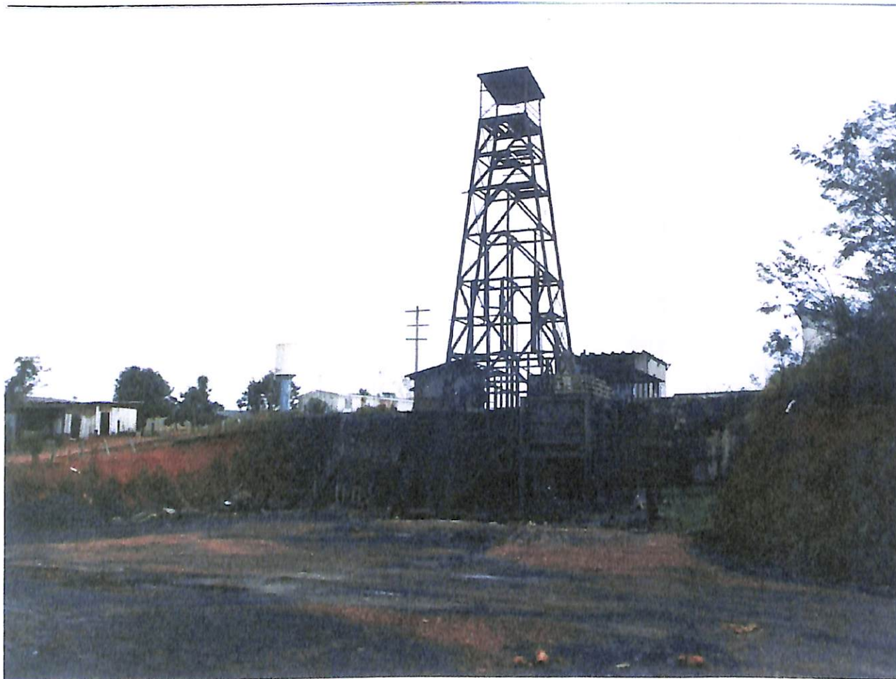
Figura 7: Foto da entrada do Poço 06 – Mina Amando Simões.
