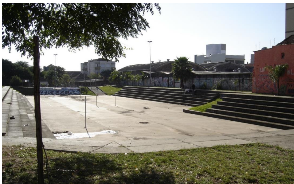
Figura 10: Exemplo de bacia de retenção na cidade de Porto Alegre
