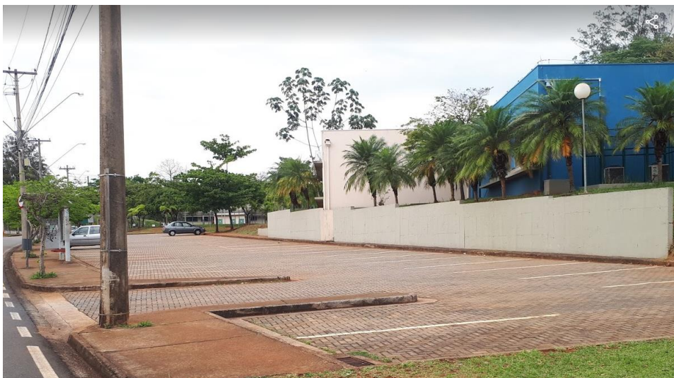
Figura 30: Exemplo de pavimento permeável utilizado no campus, próximo ao Instituto de Economia.
