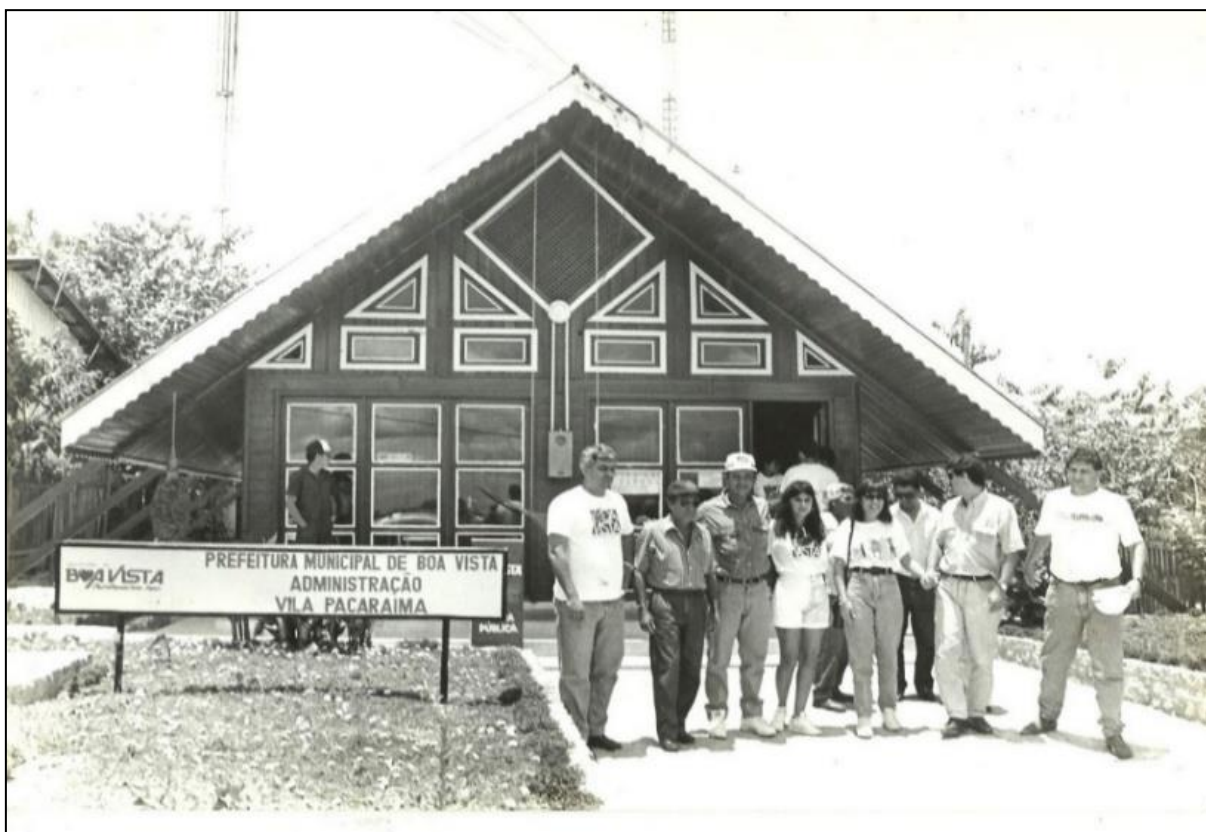
Figura 14 – Vista da fachada da sede da administração da Vila Pacaraima em 1993
