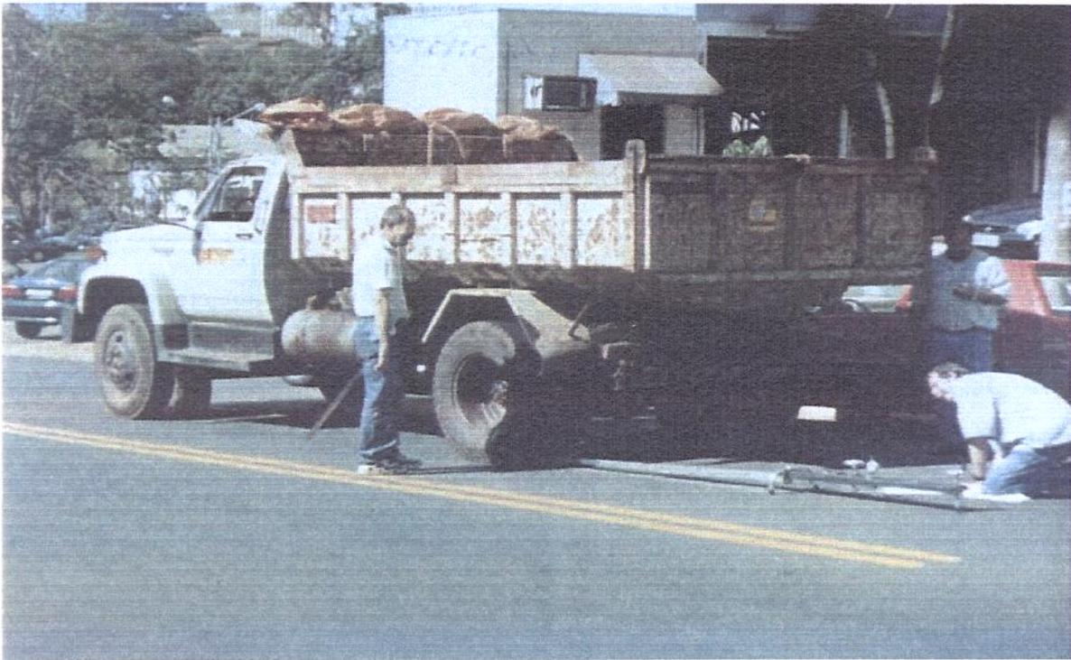
Figura 1 – Vista geral do levantamento com a viga Benkelman
