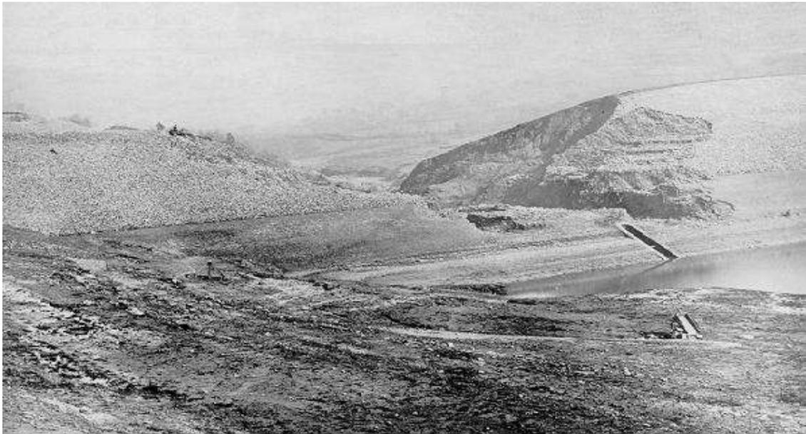
**Figura 1 - Visão do maciço a partir de dentro do reservatório após o rompimento. Fonte: <http://www.mick-armitage.staff.shef.ac.uk/sheffield/photogal/picflud1.html>**
