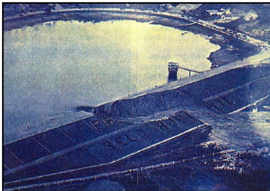
**Figura 4 - Rompimento provocado por erosão interna na barragem da Pampulha em Minas Gerais.
