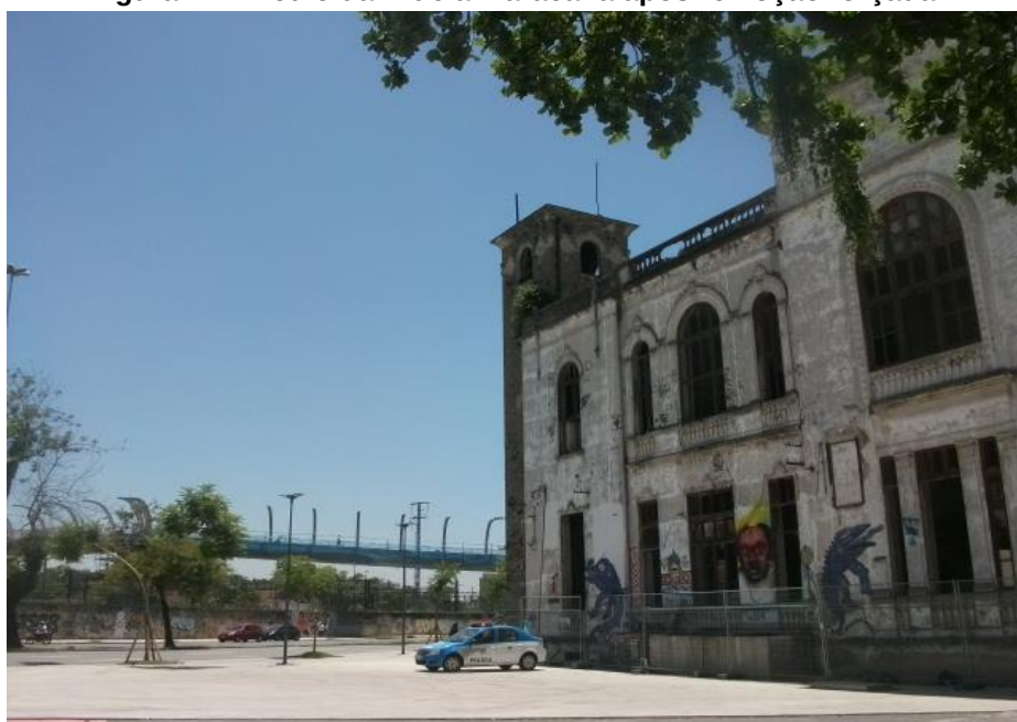
Figura VI - Prédio da Aldeia Maracanã após remoção forçada.
