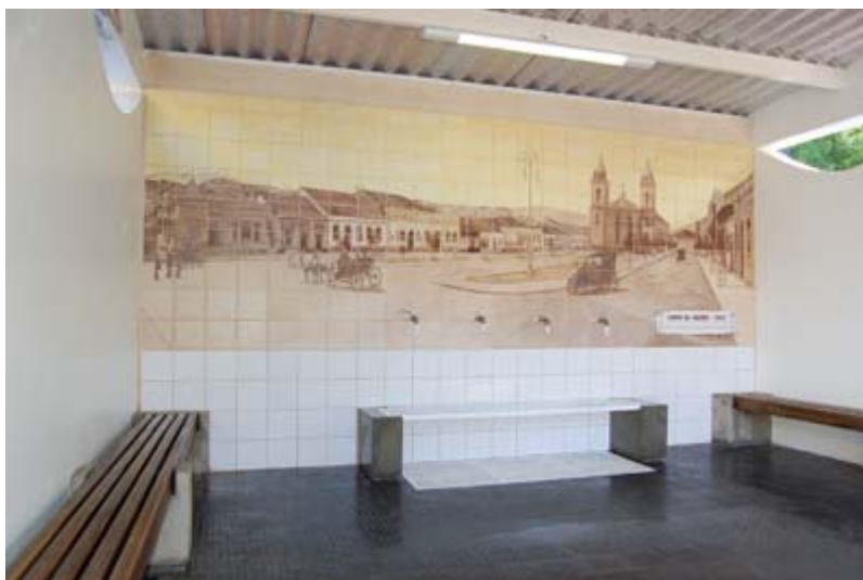
Figura 25. Fonte Nossa Senhora do Amparo após todas as intervenções
