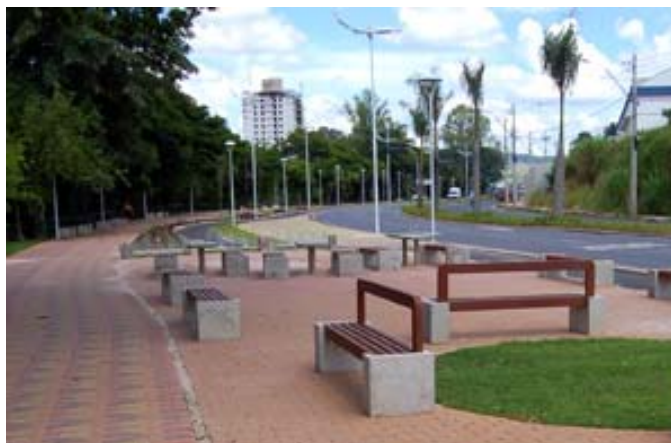
Figura 36. Trecho do Parque Linear Águas do Camanducaia
