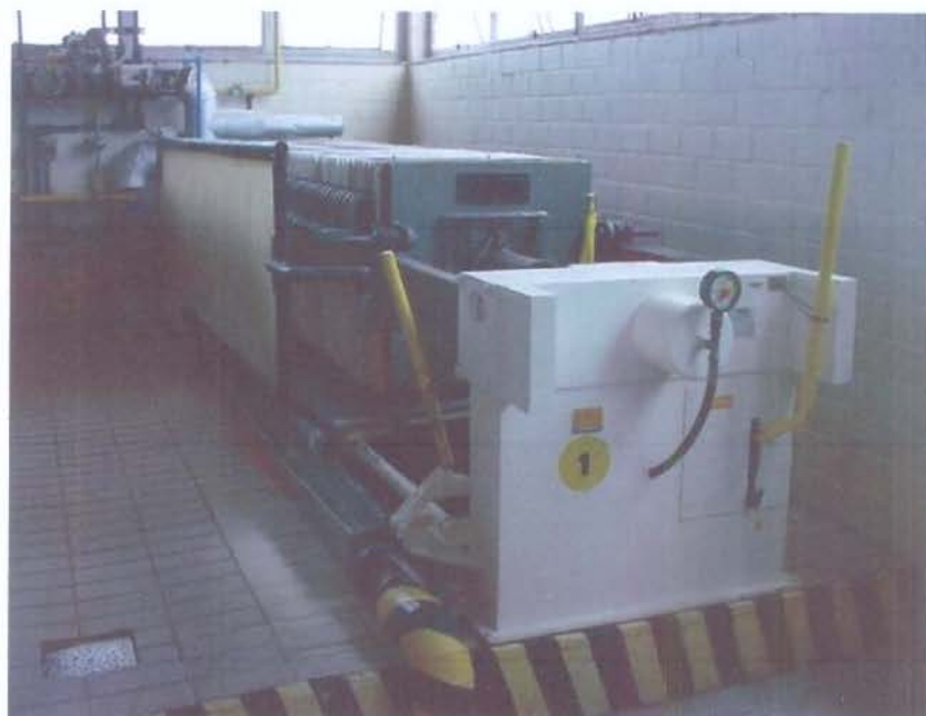
Foto 4: Filtro prensa manual.
