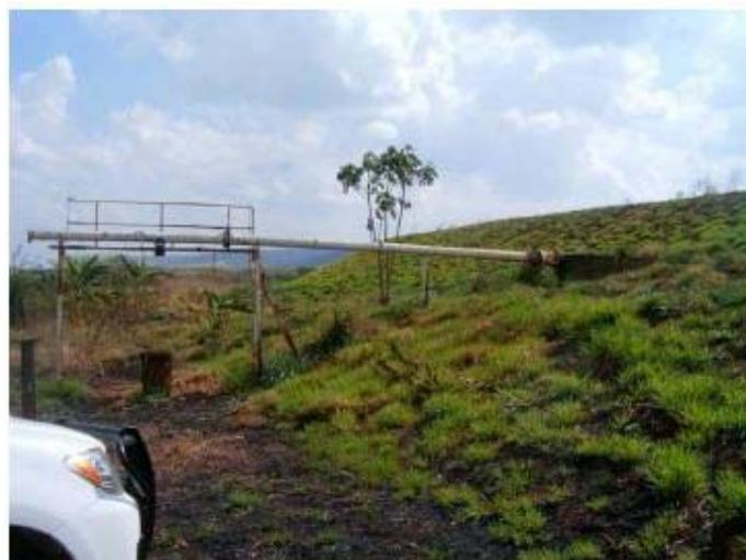
Figura 4. Tubulação utilizada para transferência da vinhaça do tanque para os caminhões.
