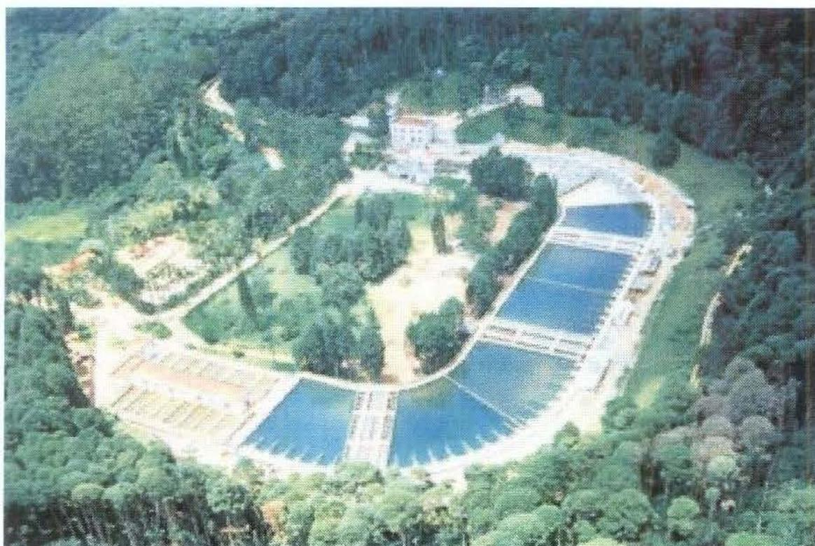
O tratamento de água se compõem em várias estágios sendo que cada uma delas é responsável por uma etapa do tratamento que vai da limpeza mais grossa (retirada de folhas e substancias sólidas) até a fluoretação que constitui no adcionamento de fluor na água para fins medicinais.
