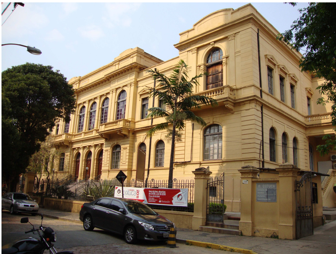
Figura 3: Visão Parcial do edifício Profissional Bento Quirino, atual Colégio Técnico da Unicamp, 17/09/2010.
