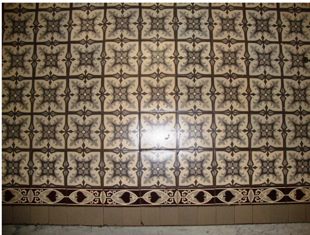
Figura 19: piso utilizado no pavimento térreo, 17/09/2010.
