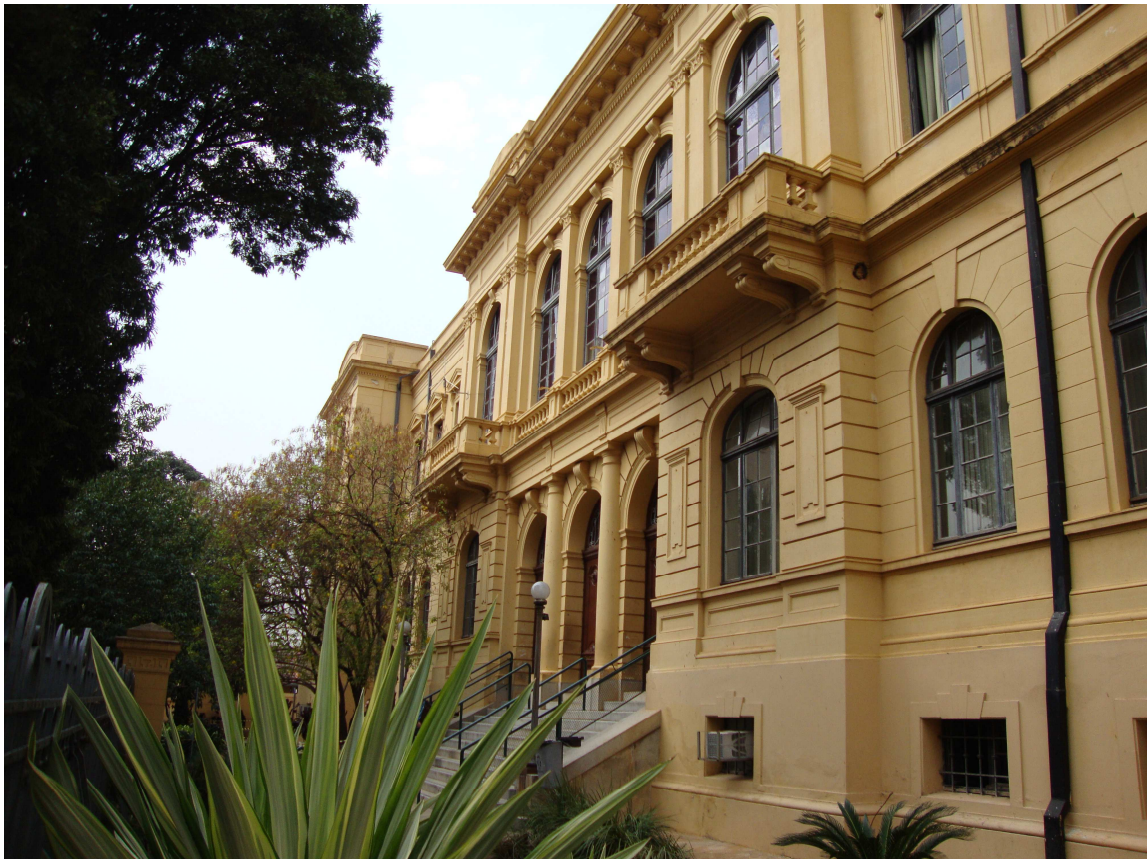
Figura 27: Visão da Fachada do edifício Principal, 17/09/2010.
