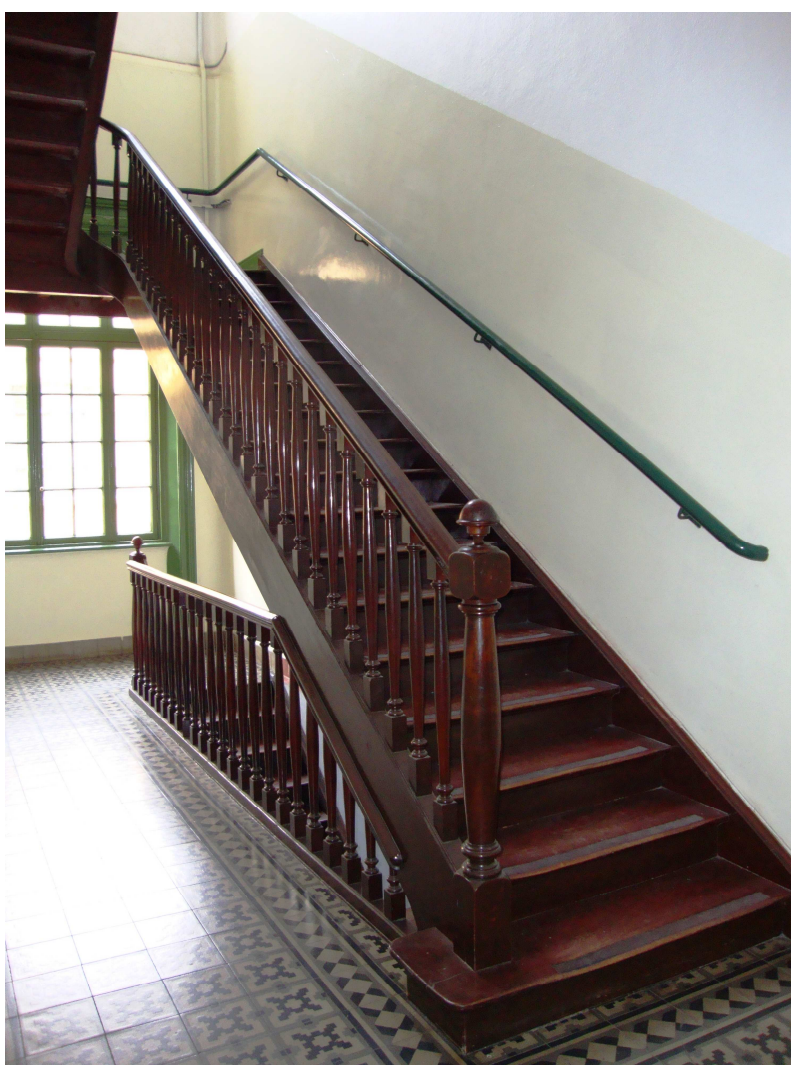
Figura 17: visão parcial da escadaria secundária, 17/09/2010.
