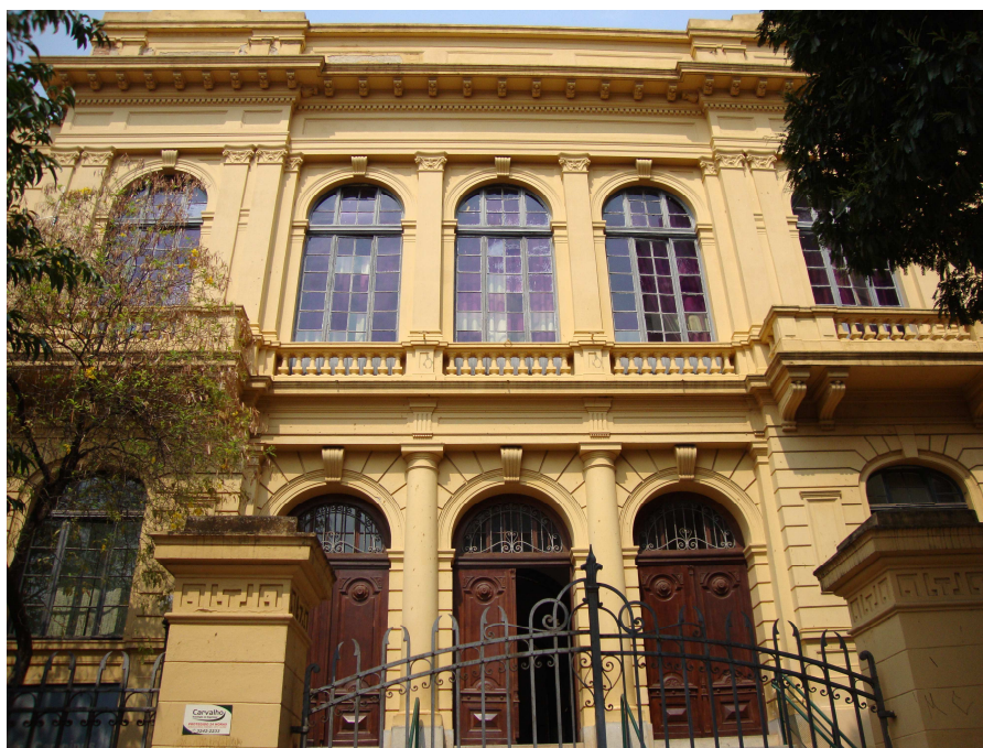
Figura 13: Visão Parcial da Fachada do Edifício Principal, 17/09/2010.
