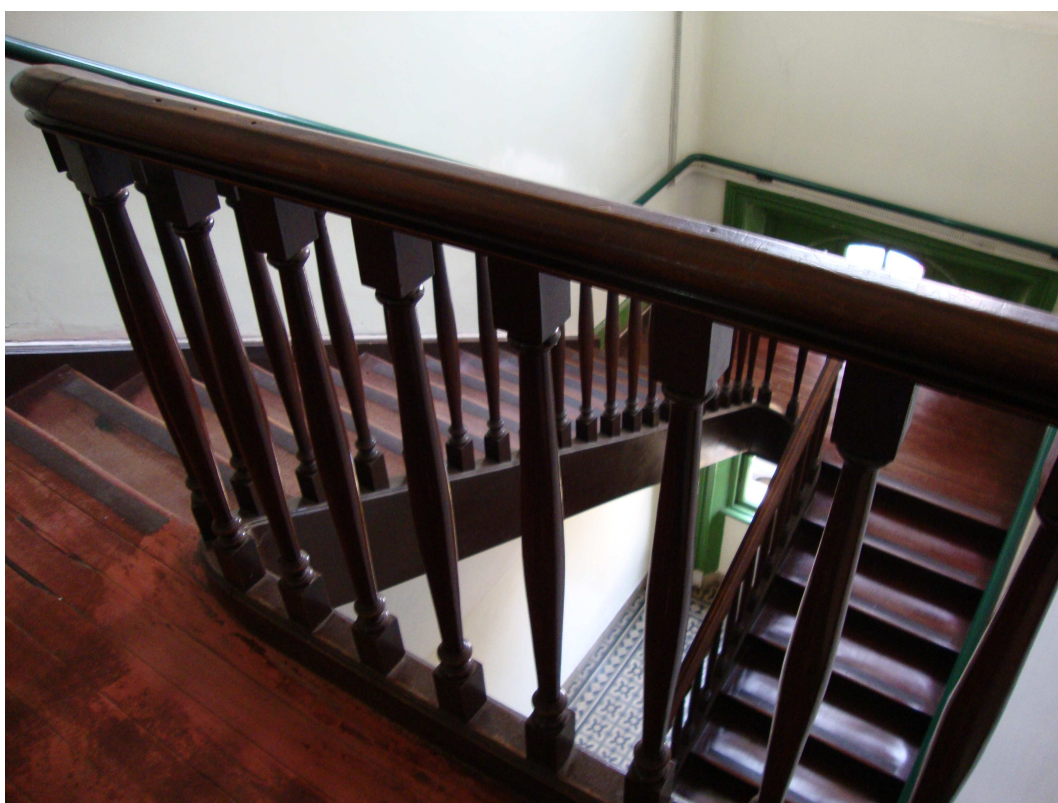
Figura 25: visão parcial da escada secundária, 17/09/2010.
