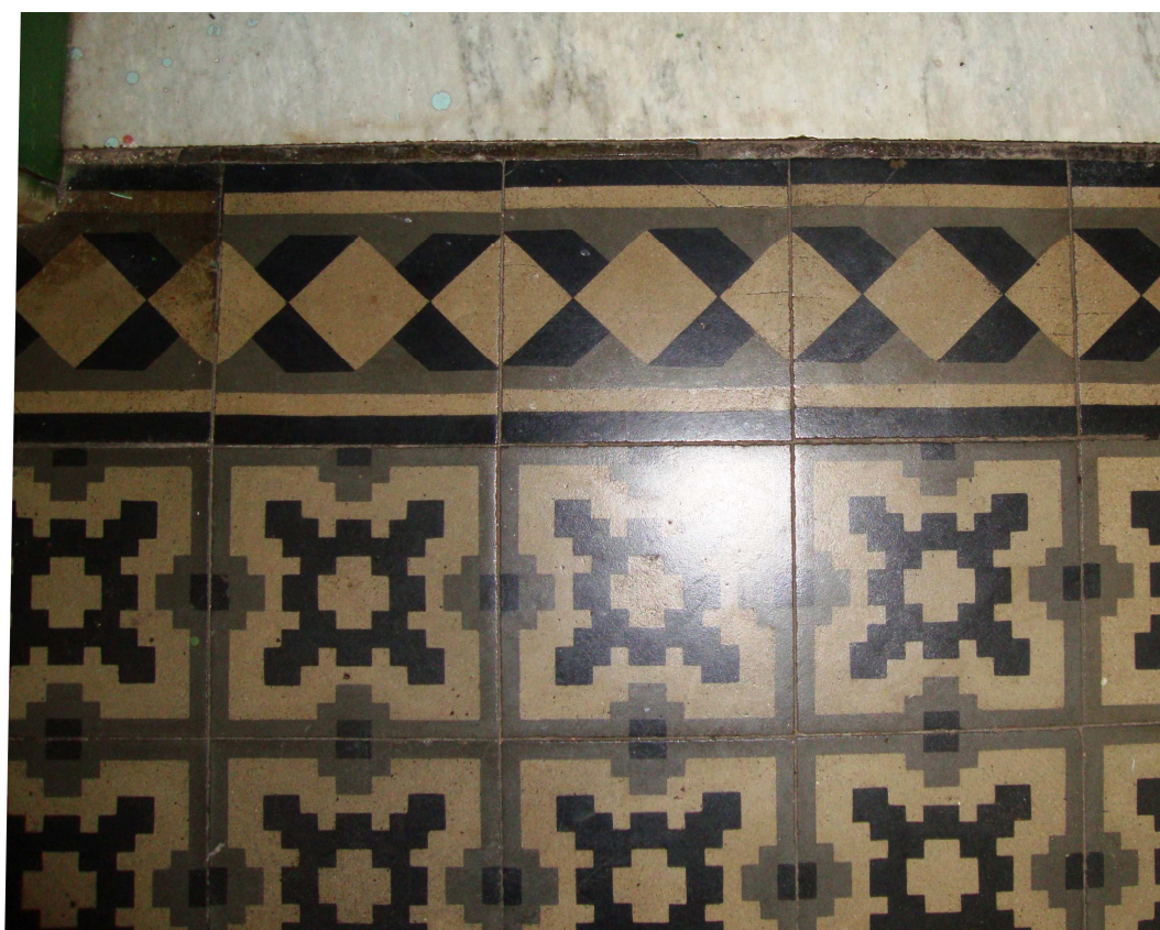
Figura 20: piso utilizado no pavimento térreo, 17/09/2010.
