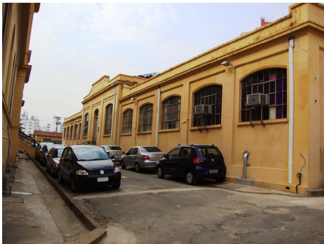
Figura 26: visão parcial do edifício das Oficinas, 27/09/2010.
