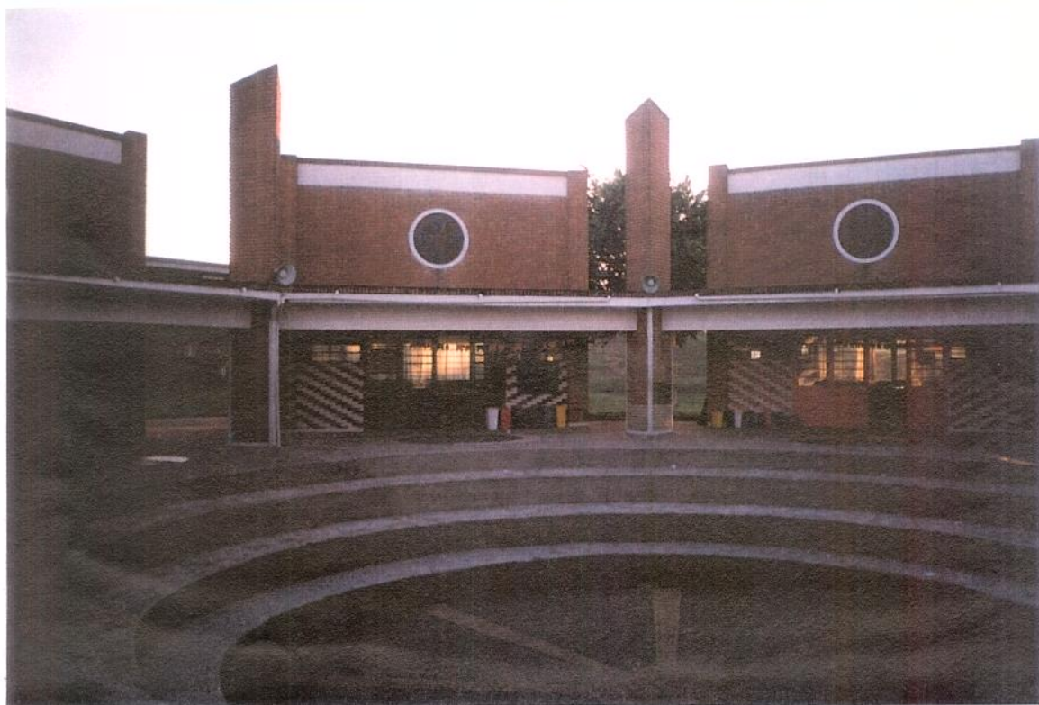
ESTRUTURA FÍSICA INTERNA.
