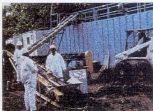
Figura IX: Solo contaminado sendo colocado na esteira para o biorreator.
