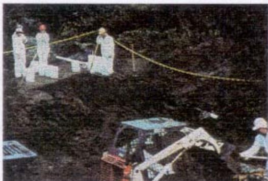
Figura VIII: Isolamento e escavação de área contaminada para retirar o solo comprometido
