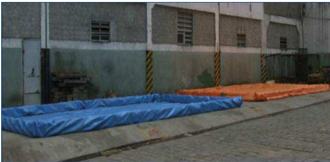
**Figura 4.3:** Tanques abertos impermeabilizados com mantas de PVC utilizados para realização da lavagem oxidativa do solo (imagem obtida em outubro de 2008).
