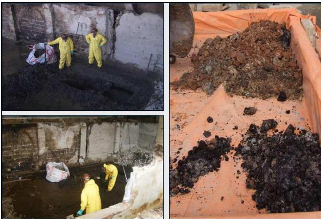
**Figura 4.4:** Solo contaminado sendo escavado e transferido para o local de tratamento (imagem obtida em outubro de 2008).
