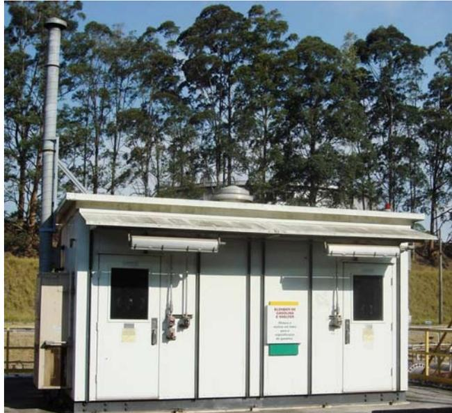
**Figura 91.** Casa de analisadores do sistema de mistura de gasolina.
