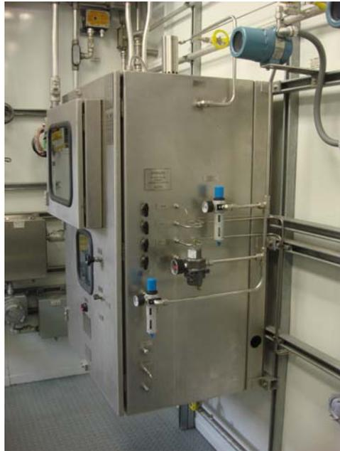
**Figura 92.** Analisador NIR instalado na casa.
