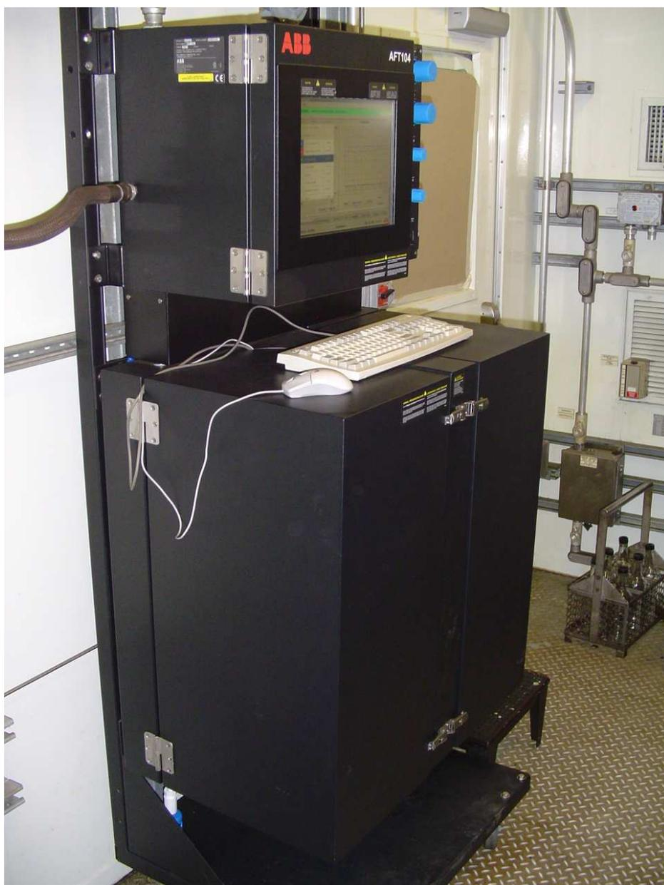
Fig. 21 – Espectrofotômetro MID/NIR de processo instalado na casa de analisadores.
