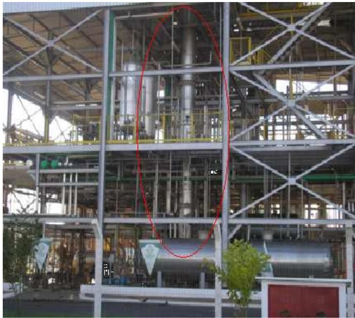
Figura 4.1: Ao centro da foto, a coluna de destilação da usina Barralcool (foto tirada em 04/01/2008).
