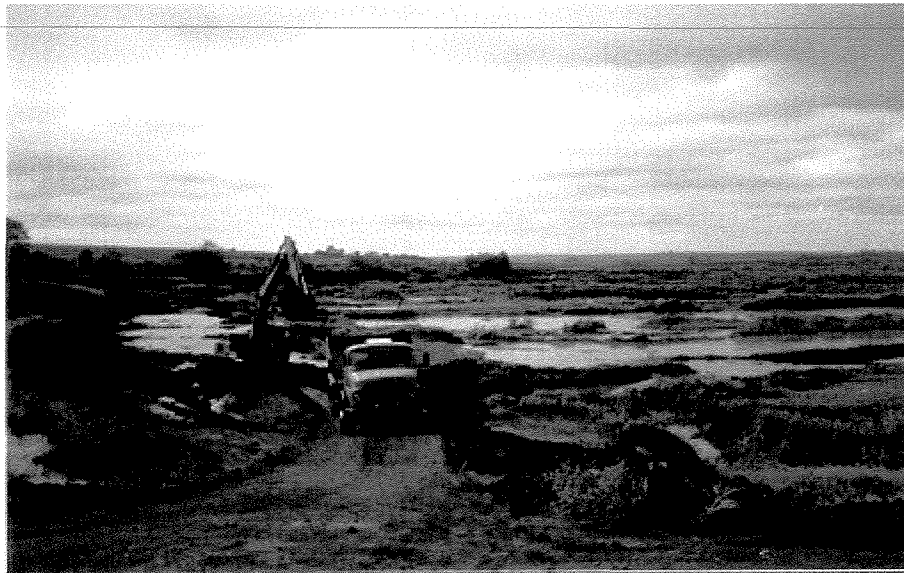
Foto 4.2 - Área da Lavra na Fase de Desenvolvimento
