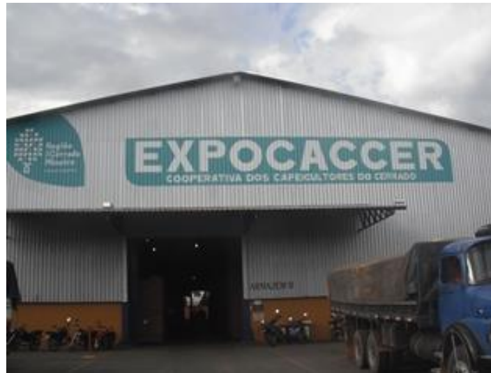
Foto 4.1 - Armazém EXPOCACER, município de Patrocínio
