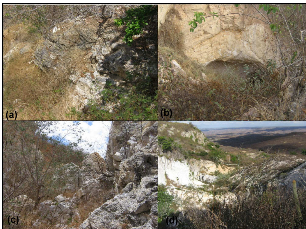
FIGURA 2.5 – Aspectos gerais dos pegmatitos: (a) Seridozinho; (b) Sítio Melado; (c) Alto dos Mamões; (d) Pitombeiras. Situação de abandono dificulta o acesso e gera situações de riscos por desmoronamentos de galerias e poços como no pegmatito Pitombeiras.
