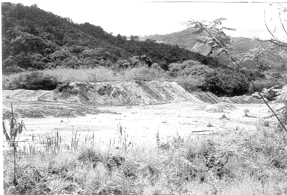
Foto 11: Pilha de rejeito proveniente do processo de beneficiamento do minério de chumbo, produzido pela refinaria Plumbum
