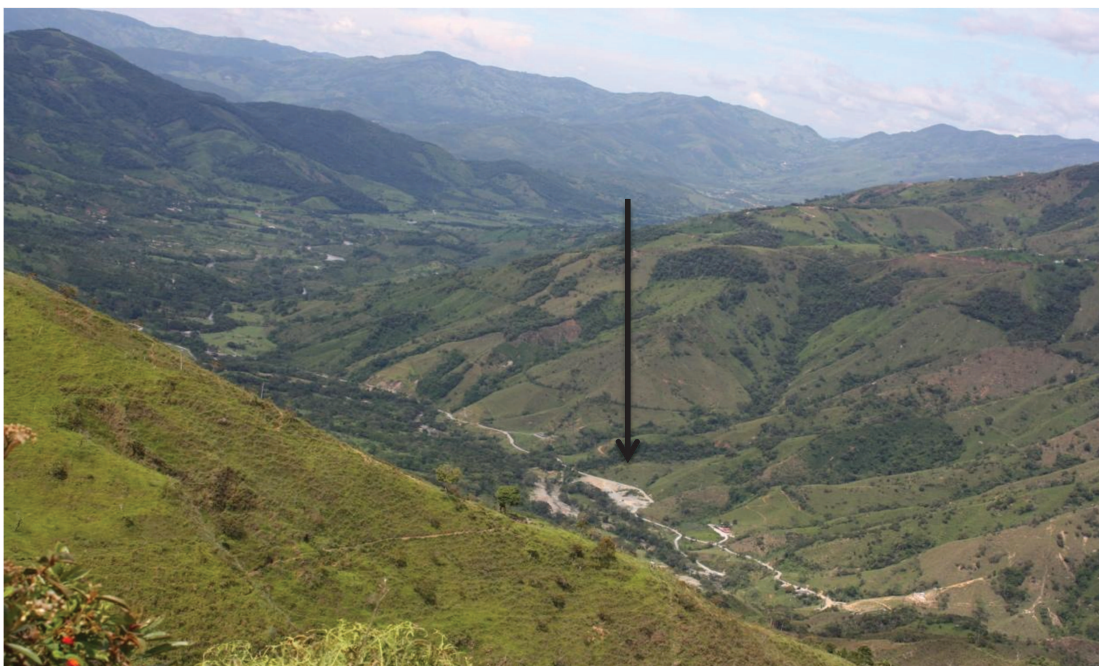
Fotografia 13 - Vista panorâmica das obras PCH Hidromontañas S.A. Fonte: Arquivo fotográfico pessoal (OCHOA, 2012).
