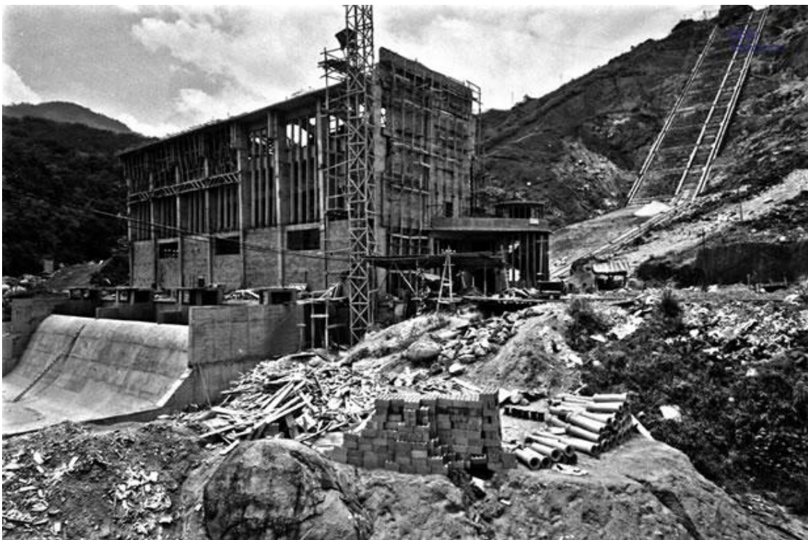
Fotografia 04 - Central hidroeléctrica Guadalupe I, um ano antes da sua inauguração em 1932. Fonte: < http://www.eafit.edu.co/memoriaempresarial/contenidos-multimedia/imagenes/Paginas/guadalupe-1931.aspx >. Acessado em: março de 2013.
