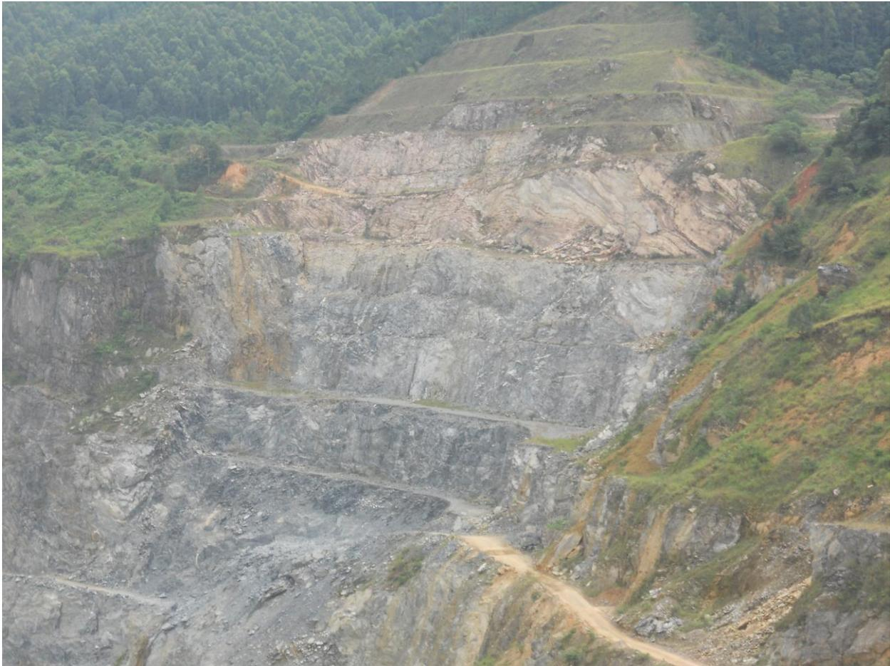
**Figura 8. Fotografia apresentando dobras identificadas na Pedreira Lafarge, município de Cajamar, 2012. Os cortes são feitos por meio de bancadas, para facilitar o trânsito de veículos e equipamentos**
