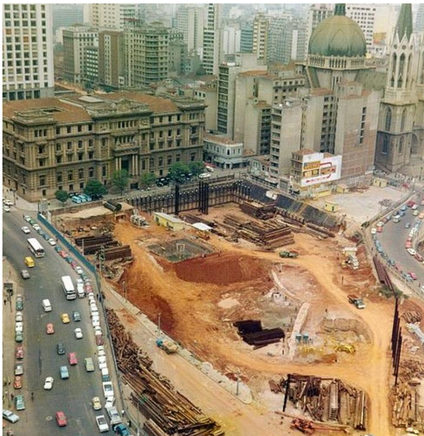
Figura 5 – Construção da Estação Sé (1972). Fonte: Metrô.
