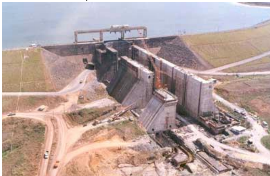
Foto 3.5 – Construção da Eclusa da Usina Hidrelétrica de Tucuruí
