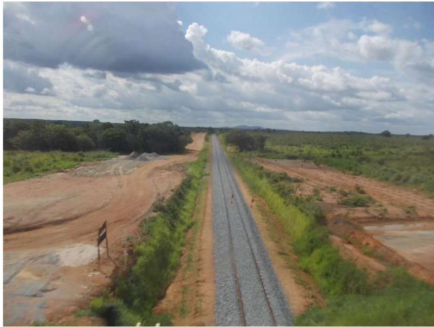
Foto 3.2 – Ferrovia Norte-Sul. Trecho próximo ao município de Gurupi – TO (2012)
