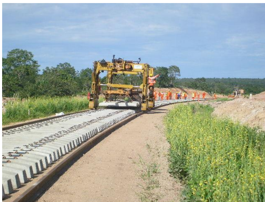
Foto 3.1 – Construção de trecho da Ferrovia Norte-Sul (2009).
