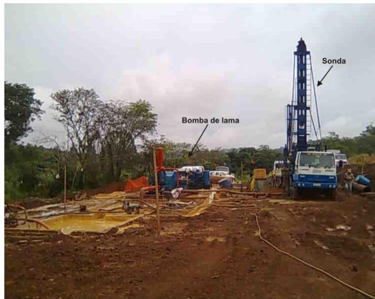
Figura 3.2. Sonda roto-percussiva.
