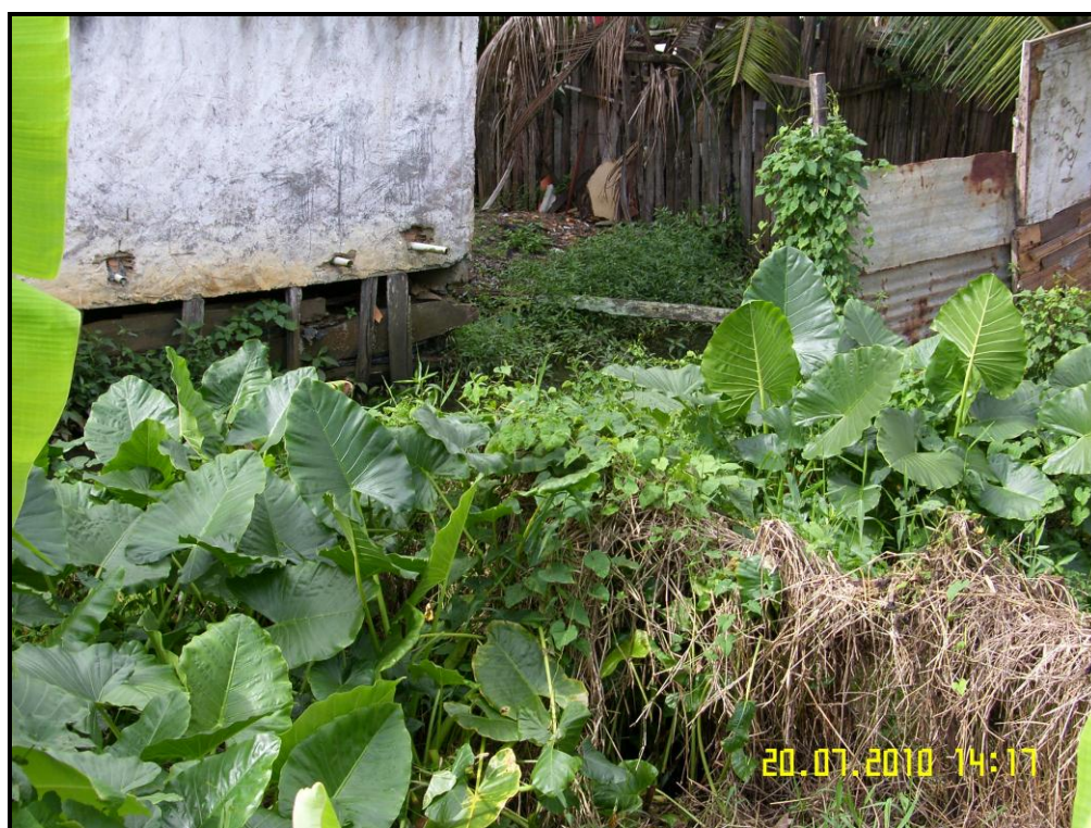
Figura 4.10 – Lançamento de águas servidas em corpo d'água na Rua da Pituba II (MATIAS, 2010).
