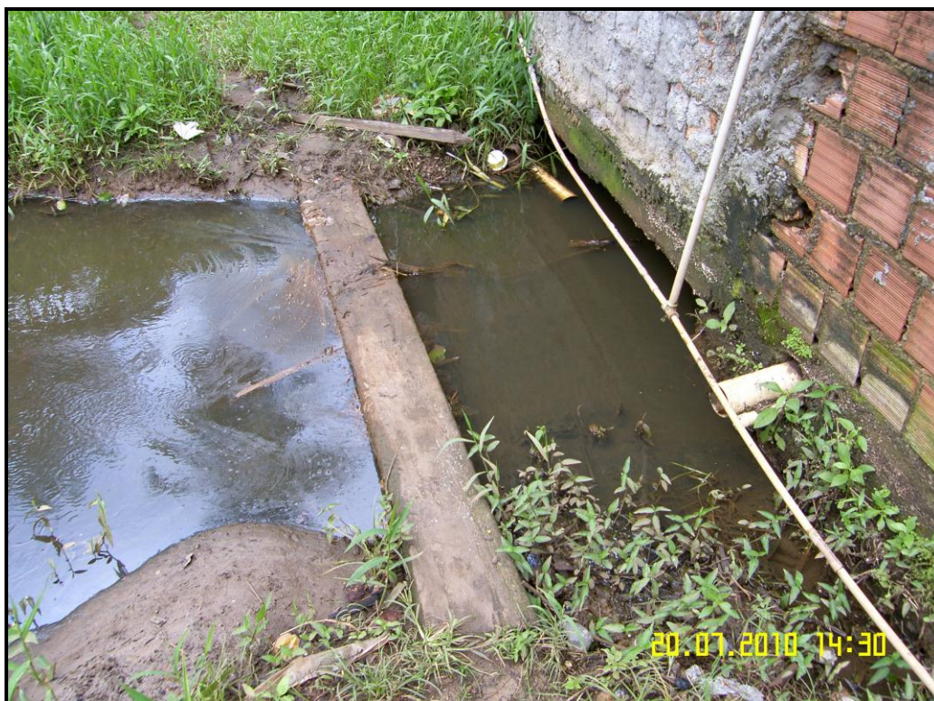
Figura 4.11 – Construção irregular e lançamento de esgoto in natura em corpo d'água no Bairro São Miguel (MATIAS, 2010).
