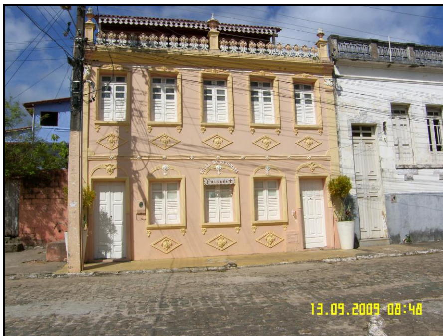
Figura 3.4 - Casa no centro de Itacaré (MATIAS, 2009).
