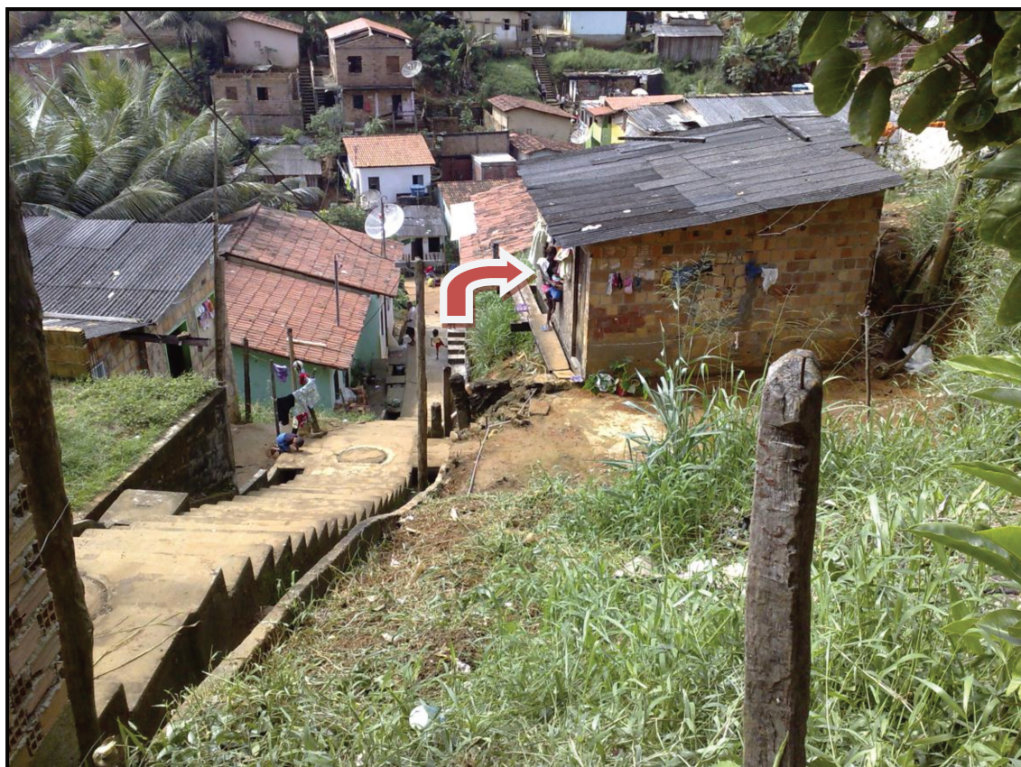
Figura 4.5 - Habitação em área suscetível a deslizamento no bairro do Santo Antônio (Bairro Novo) (MATIAS, 2010).
