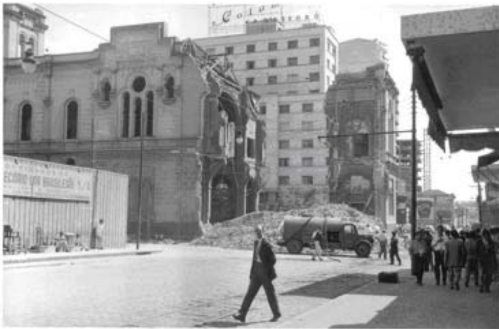
Foto 1.6 – Demolição da Catedral do Rosário em 1956
