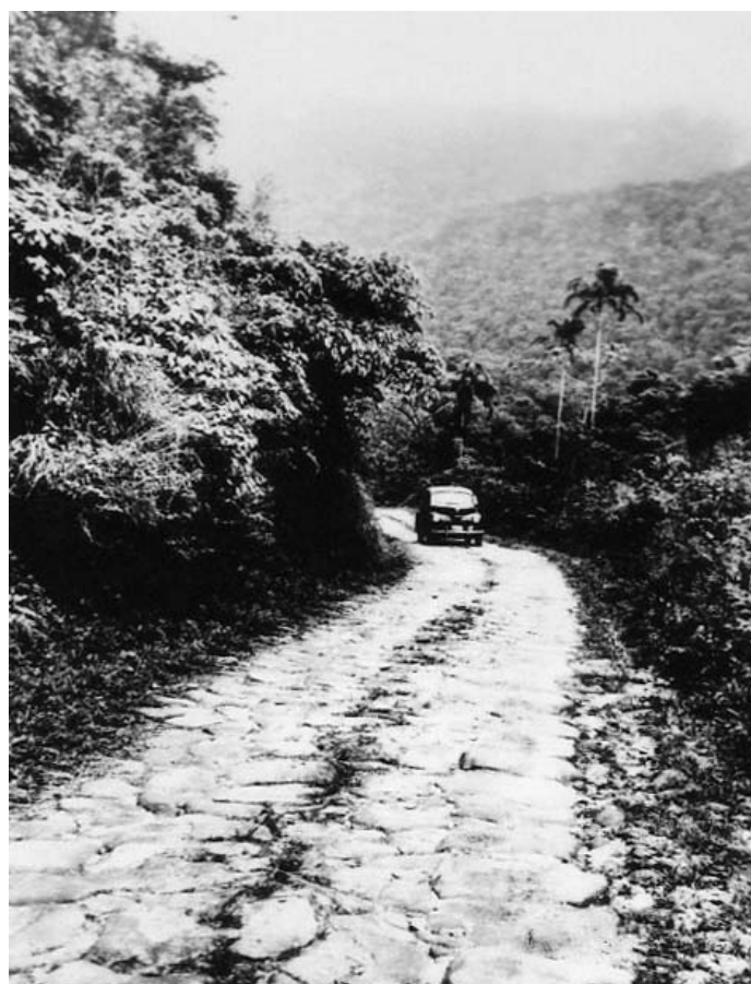
Foto 3.2: SP-Rodovia Taubaté-Ubatuba/Calçada de Ubatuba, nos anos de 1950. Atual Rodovia Osvaldo Cruz. Fonte: Arquivo de Obras Raras - FAU-USP
