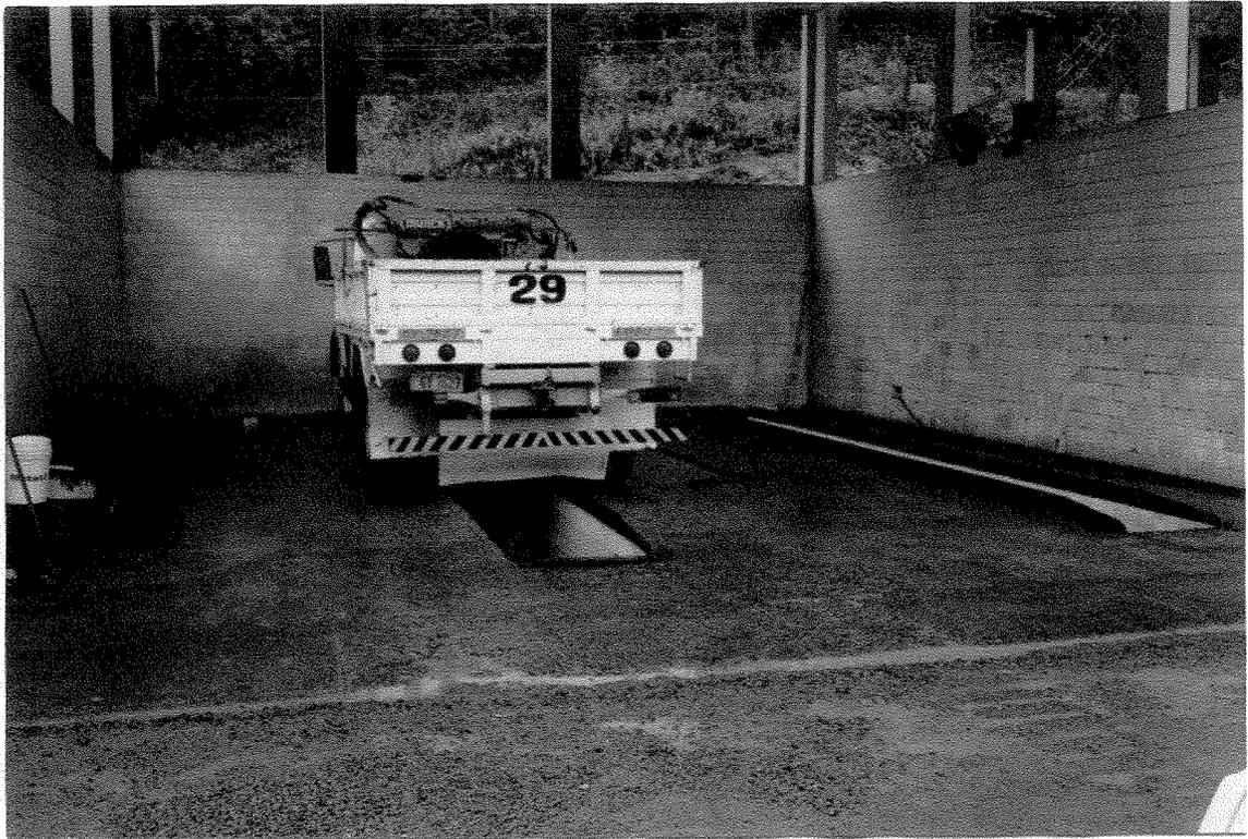
**FOTO IV.8 - Rampa de lavagem de equipamentos (Pedreira Embu)**
