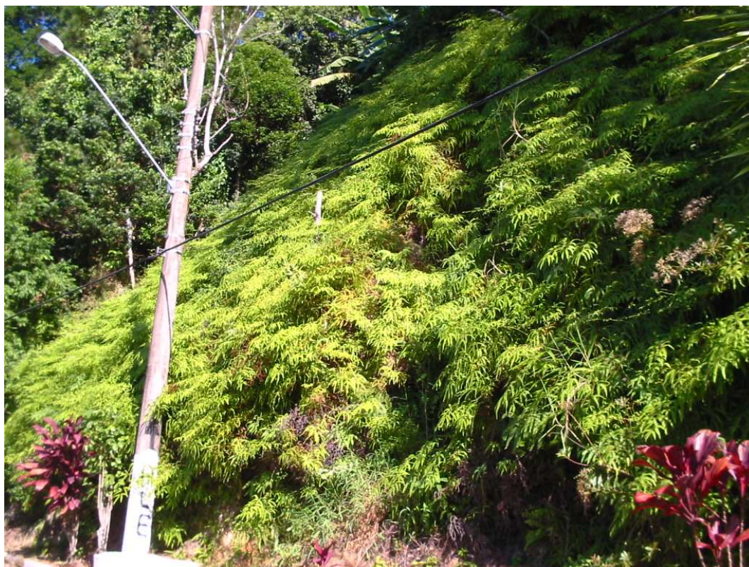
Figura 6.5 – Samambaia em cicatriz de deslizamento de encosta
