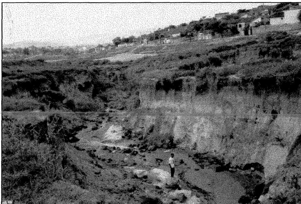
Figura 1.2 – Foto da Voçoroca entre conjuntos habitacionais DIC III (direita) e DIC VI. Detalhe da profundidade e extensão da voçoroca, ocupando grande parte da área destinada à implantação de sistema de lazer. 1992.
