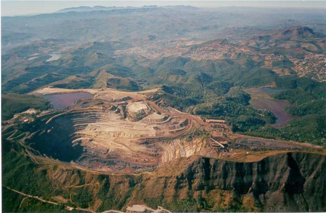
*Foto 7.1. Vista geral da cava da Mina de Águas Claras, em 1998, incluindo a barragem de rejeitos (Barragem 5) à direita e dique de rejeitos (Grota 3 PFF) à esquerda. Fonte: MBR.*
