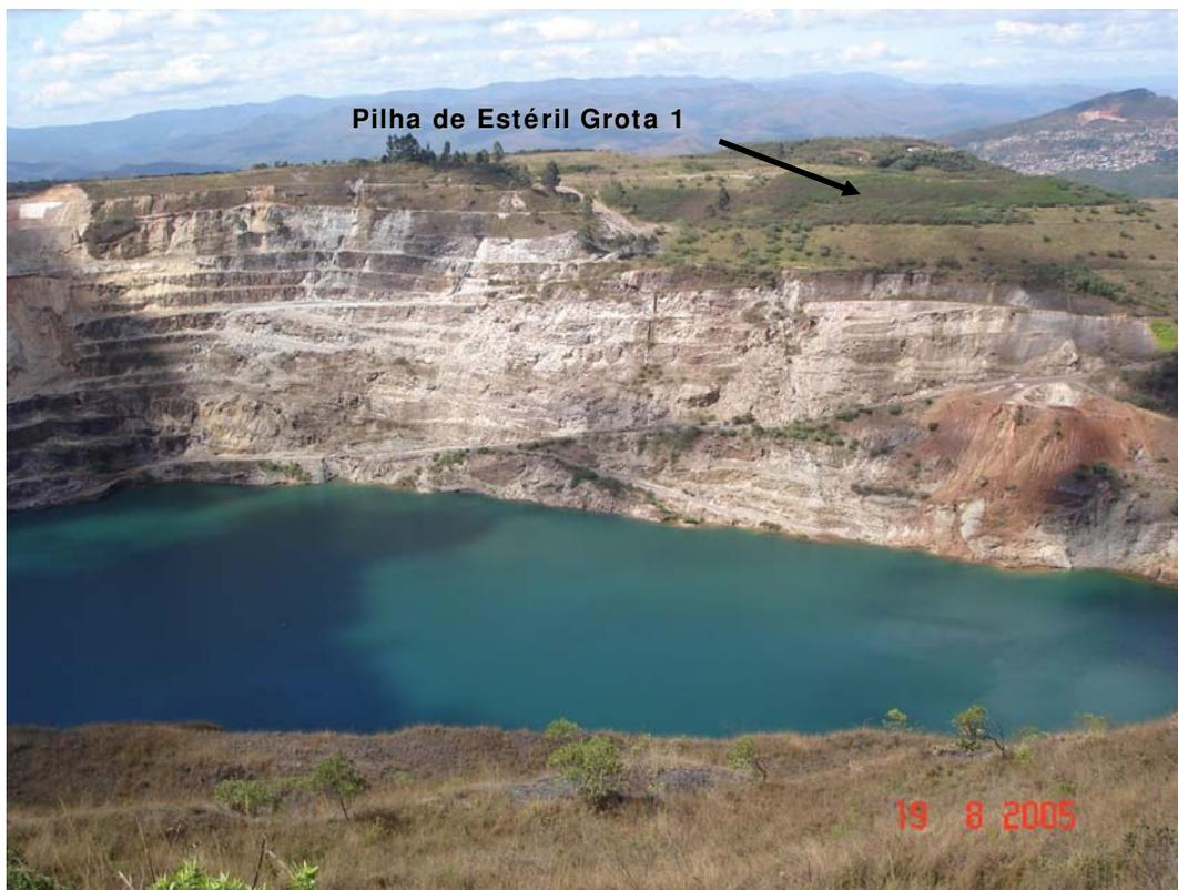
*Foto 7.3. Pilha de estéril Grota 1, após reconformação topográfica e revegetação.*
