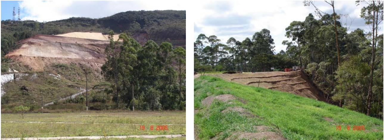
Foto 7.6. À esquerda, vista do talude da pêra ferroviária; à direita, detalhe do sistema de revegetação de taludes.
