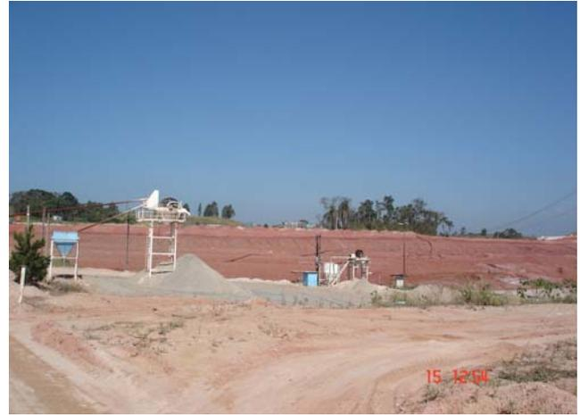
*Foto 7.13. À esquerda, antigo depósito de estéril revegetado com gramíneas e espécies arbóreas nativas da região. À direita, área minerada em processo de preparação para reabilitação (Mineração Horii).*
