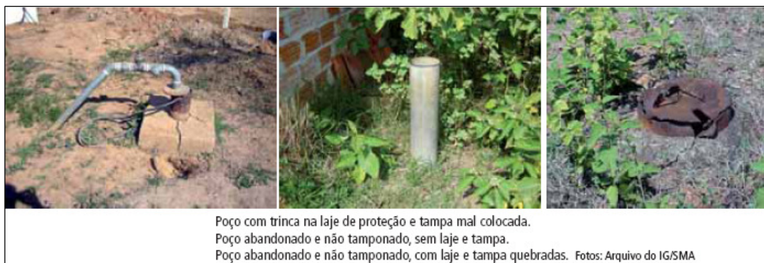
Figura 46 – Abandono de poços (aspectos).
